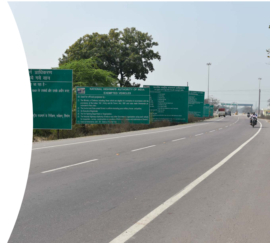
Tramo Raebarely - Banda de la Autopista NH-232, Estado de Uttar Pradesh (India)
