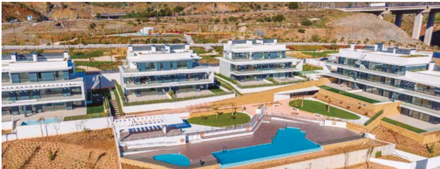
Residencial Edificio La Escala de Valdebebas, Madrid (España)
