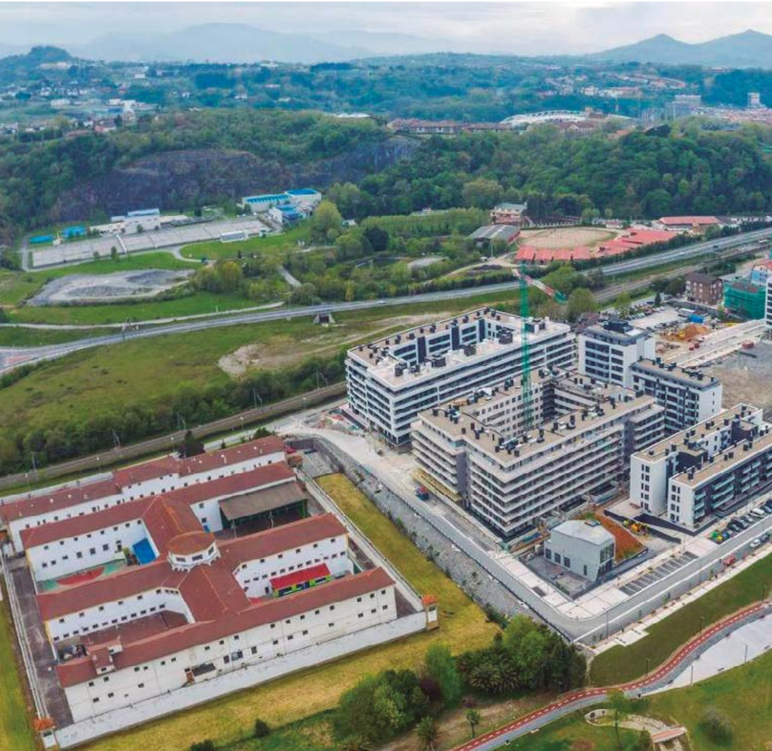
Explotación, operación y venta de energía en el Sistema de District Heating del barrio Txomin Enea de San Sebastián (España)
