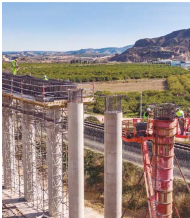
Tramo Autovía del Reguerón de la Circunvalación MU-30 de Murcia (España)
