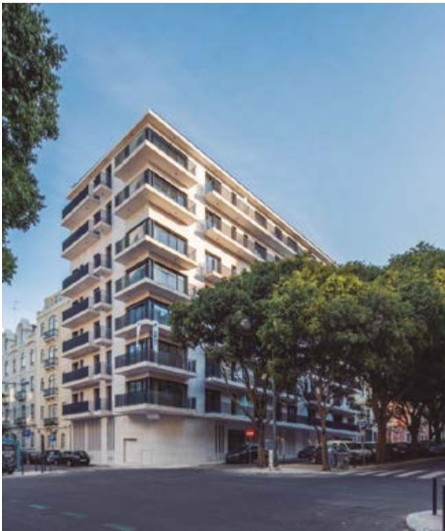
Edificio residencial Luis Bivar 26-30, Lisboa (Portugal)
