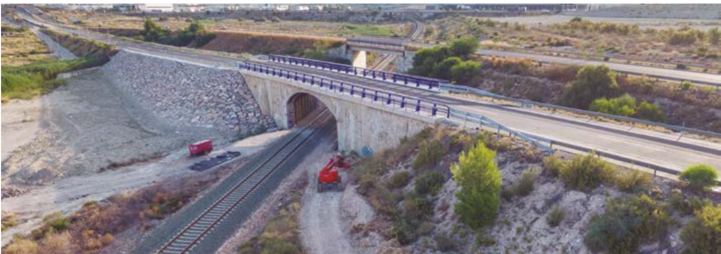
Reparación del puente sobre el ferrocarril en la N-301 en Lorquí, Murcia (España)
