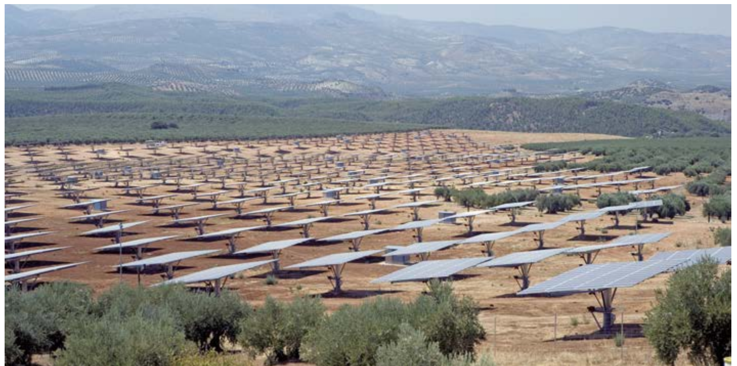
Planta fotovoltaica en Alcaudete, Jaén / 5,4 MW (España)
