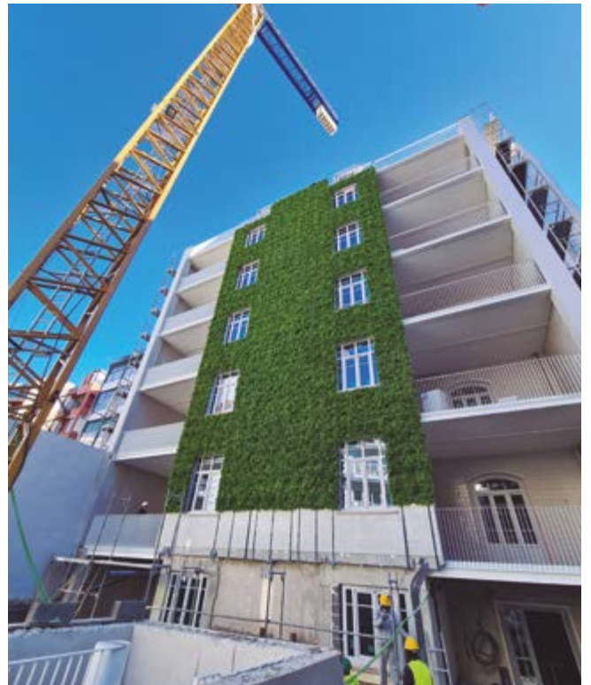
Edificios residenciales Duque Loulé 70, Lisboa (Portugal)
