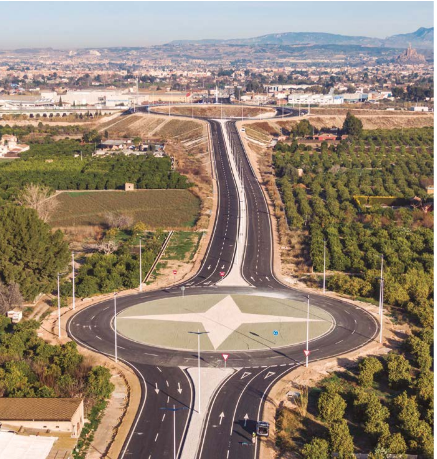
Tramo Autovía del Reguerón de la Circunvalación MU-30 de Murcia (España)
