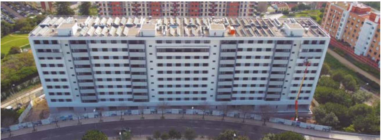
Edificios residenciales en Almarjão, Miraflores (Portugal)
