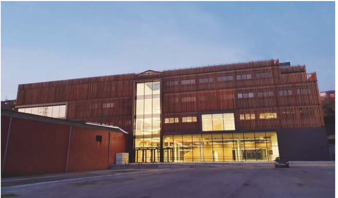
Edificio Beta 2 (Fase II) en Zorrotzaurre en Bilbao (España)
