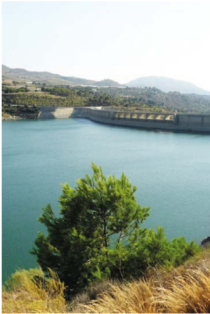
Sistema de presas Béznar - Rules, Granada. Fase I - Desglosado 9 (España)
