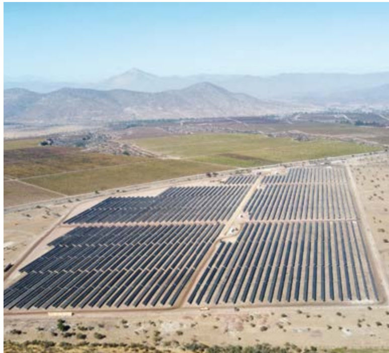
Planta fotovoltaica Los Nogales, Región de Ovale (Chile). 9,9 MW
