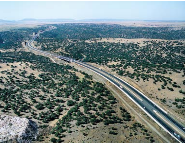
Conservación y explotación de las carreteras del Estado sector CC-0305 Cáceres (España)
