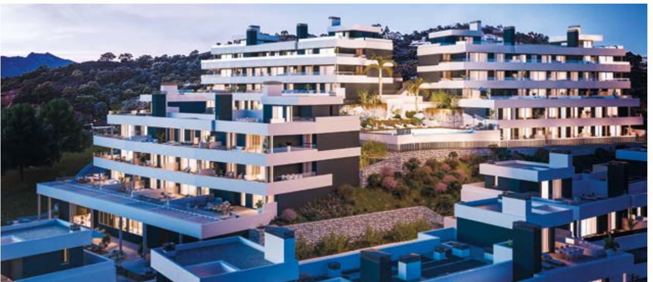
Residencial Medblue Los Monteros en Marbella, Málaga. Fases I y II (España)
