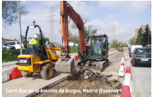
Urbanización del sector 10 de A Coruña (Parque Ofimático) (España)
