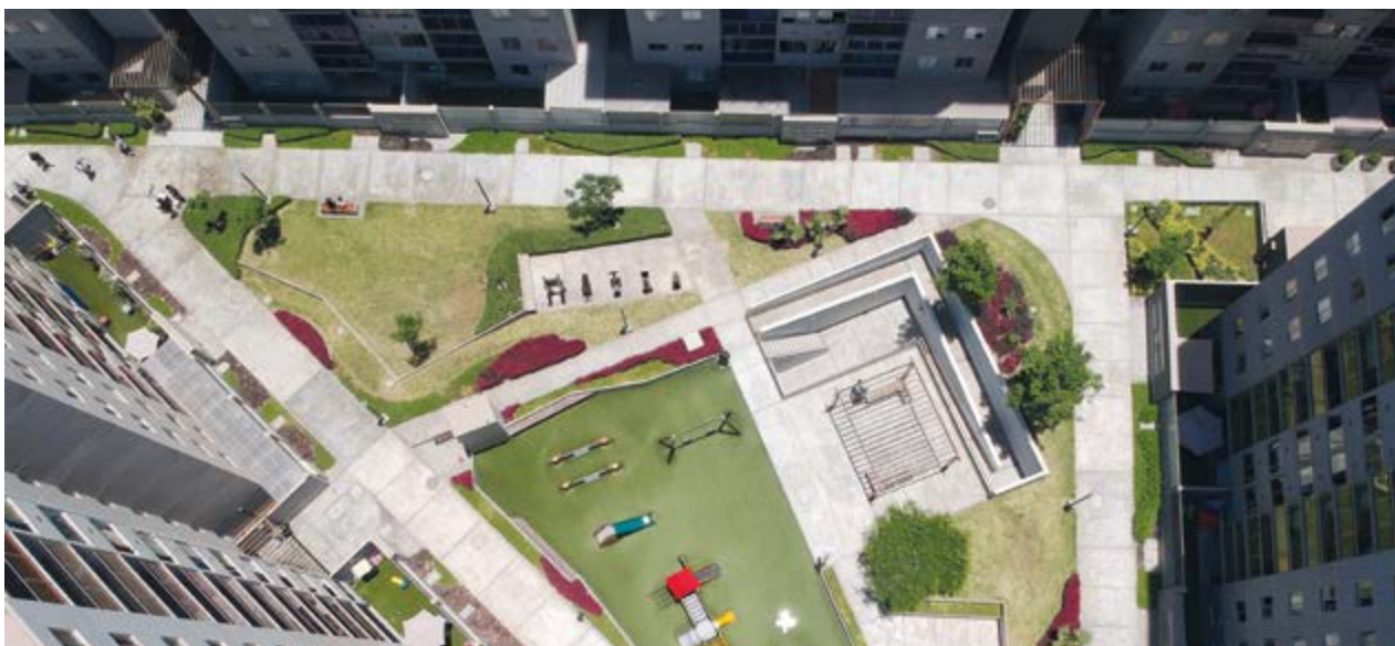
Condominio Nuevavista en el distrito de Bellavista en la Provincia de Callao -1.104 viviendas-, Lima (Perú)
