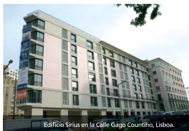
Edifício Sirius en la Calle Gago Countinho, Lisboa.
