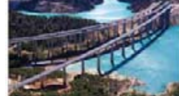
Viaducto del Istmo, AVE Madrid - Valencia
