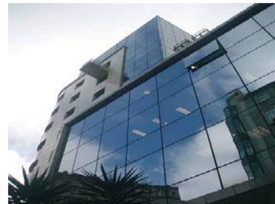
Edifício Duque de Loulé, Lisboa
