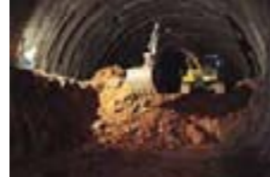
Detalle túnel, AVE Madrid - Valencia
