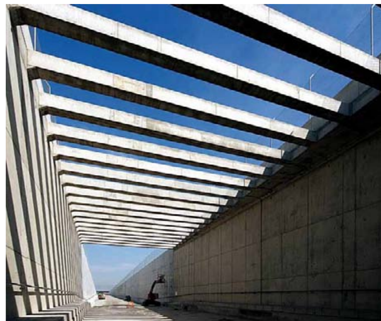
Tramo Montcada - Mollet, AVE Madrid - Zaragoza - Barcelona Frontera Francesa
