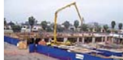
Ejecución Colegio Roosevelt en el distrito de La Molina-Lima
