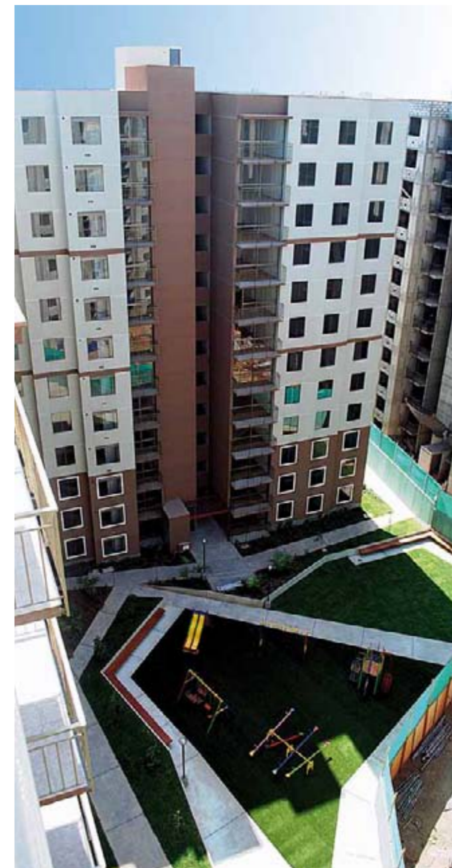
Condominio Parques de la Huaca, Lima
