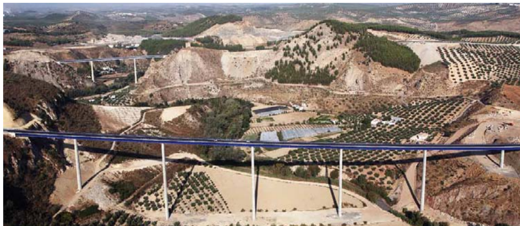
Viaducto sobre el río Genil de la A-45, Córdoba
