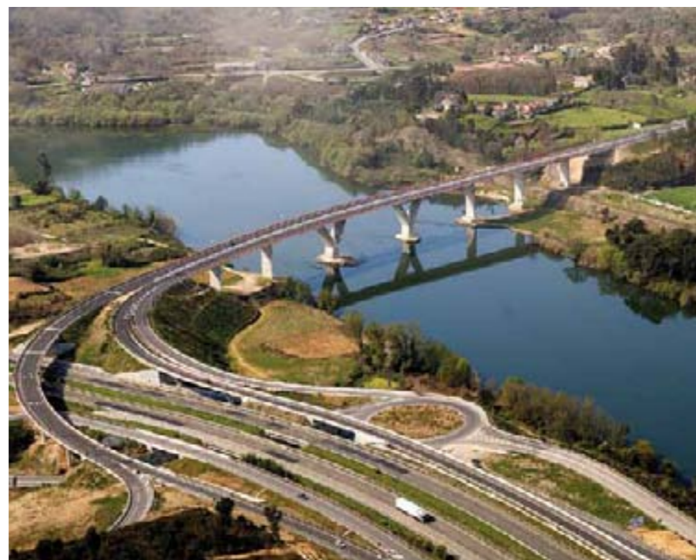
Viaducto sobre el río Miño en la AG-53, Orense
