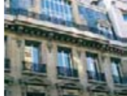
Edificio Rue de la Bienfaisance, París (Francia)
