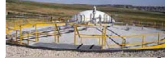
Cubierta digestor EDAR Arroyo de la Vega, Madrid
