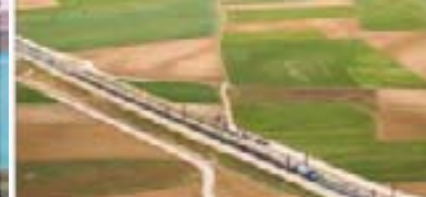
Tramo Ocaña-Villarubia, AVE Madrid - Valencia
