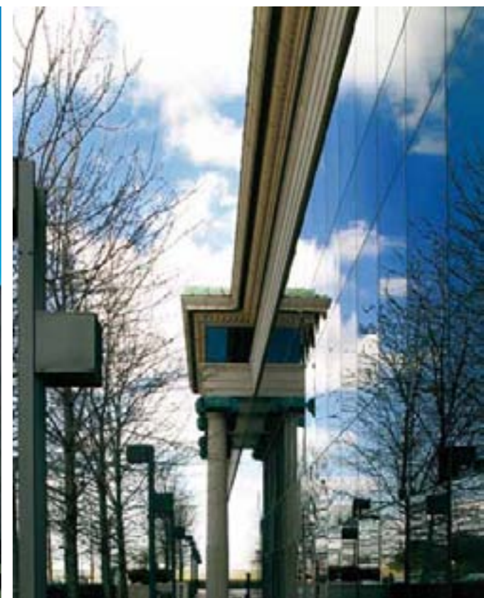
Edificio Ática 5 en Pozuelo de Alarcón, Madrid
