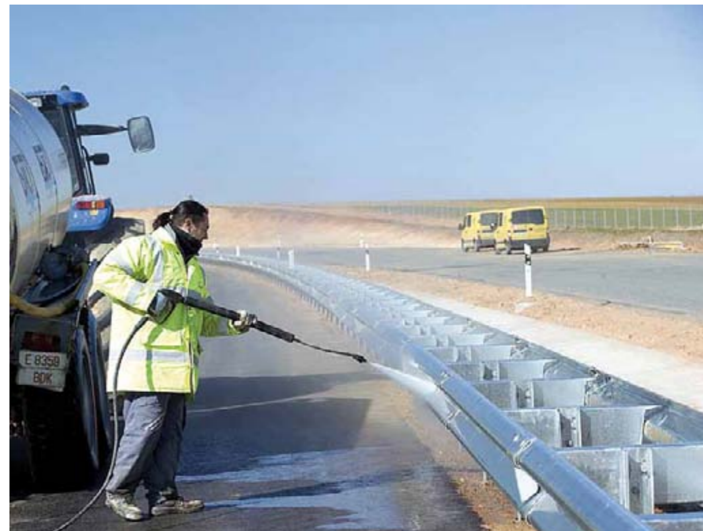
Mantenimiento de carreteras
