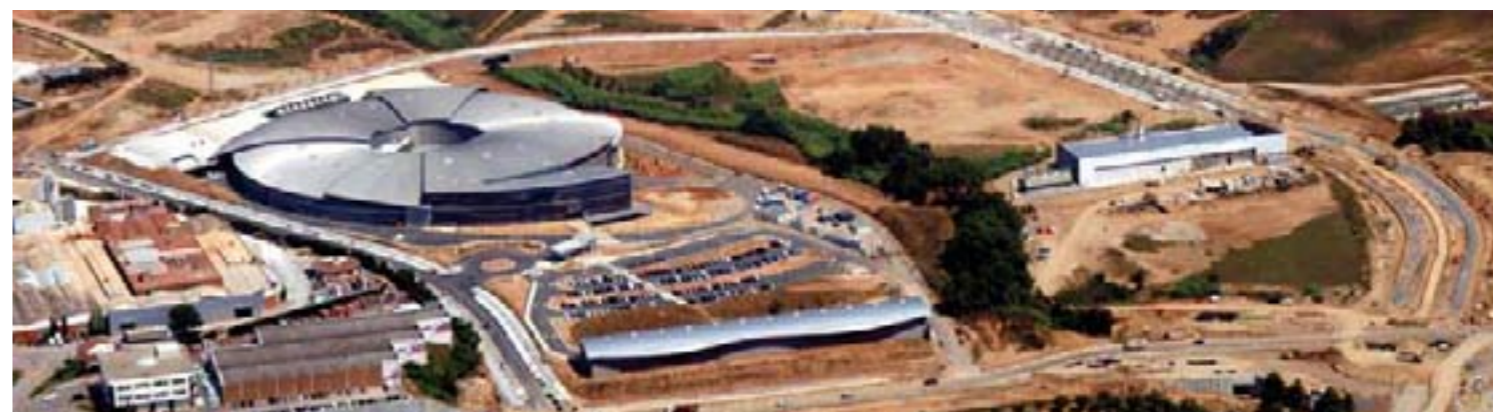
Planta de Poligeneración de frío y calor en Cerdanyola del Vallés, Barcelona
