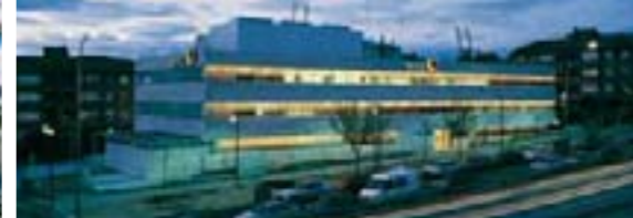
Edificio Vía Dos Castillas en Pozuelo de Alarcón, Madrid
