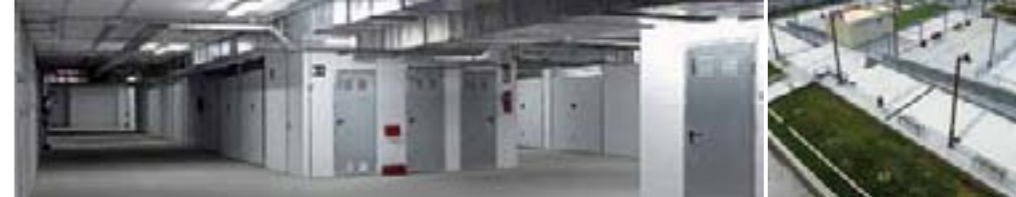
Parking subterráneo y urbanización de la Plaza Emperador Carlos en San Fernando, Cádiz
