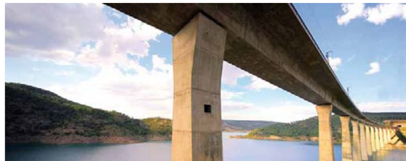
Viaducto del Istmo, AVE Madrid-Valencia
