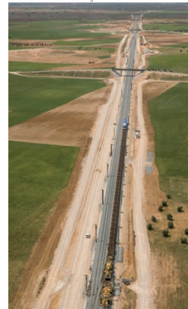
Tramo Ocaña - Villarubia de Santiago. AVE Madrid - Valencia
