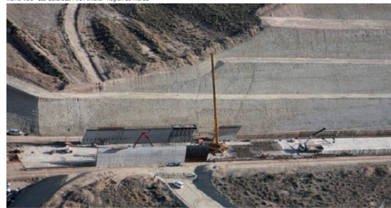
Tramo Vera - Los Gallardos. AVE Almería - Región de Murcia
