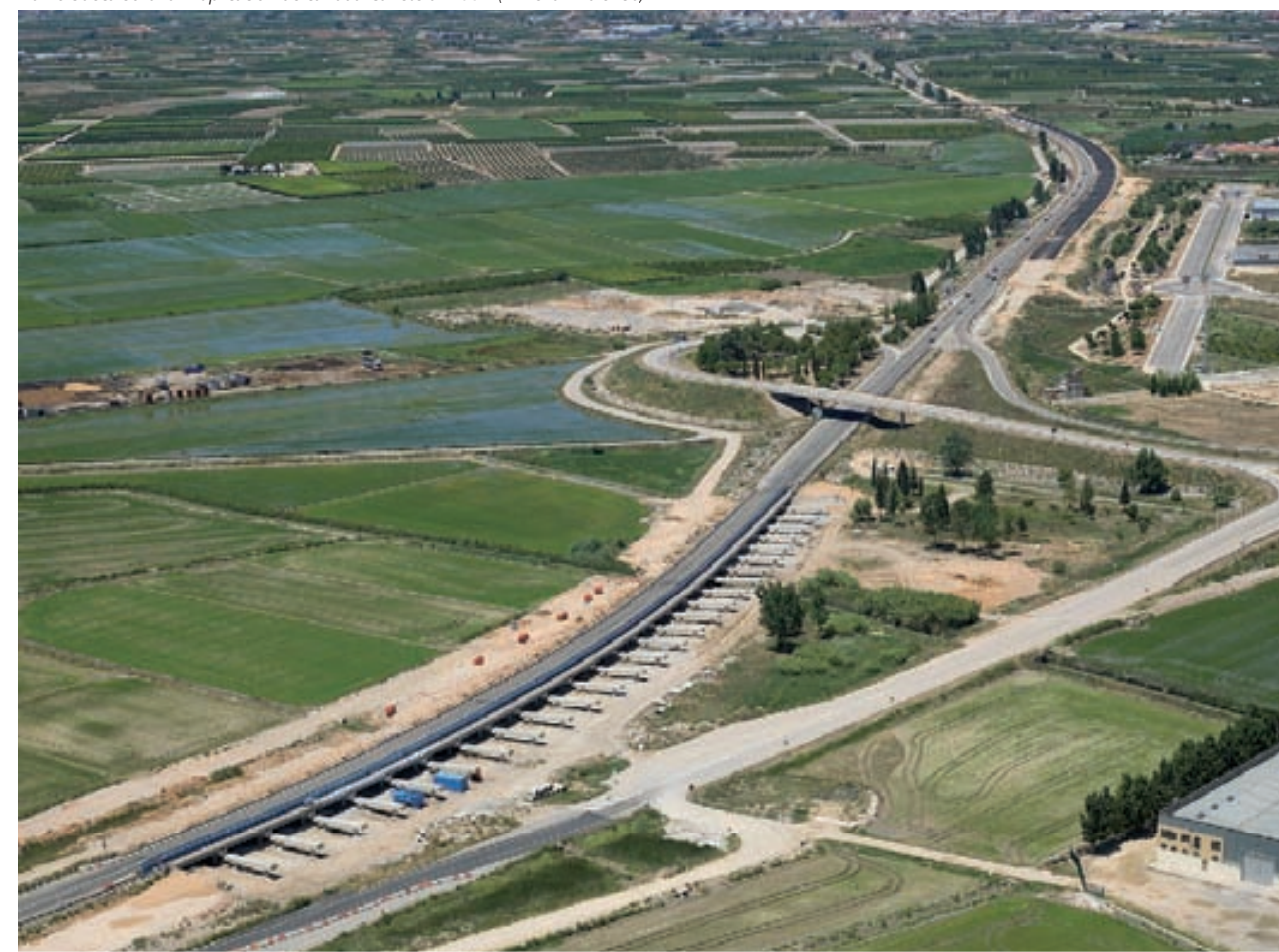
Tramo Sueca-Sollana. Duplicación de calzada Carretera N-332 (Almería - Valencia)
