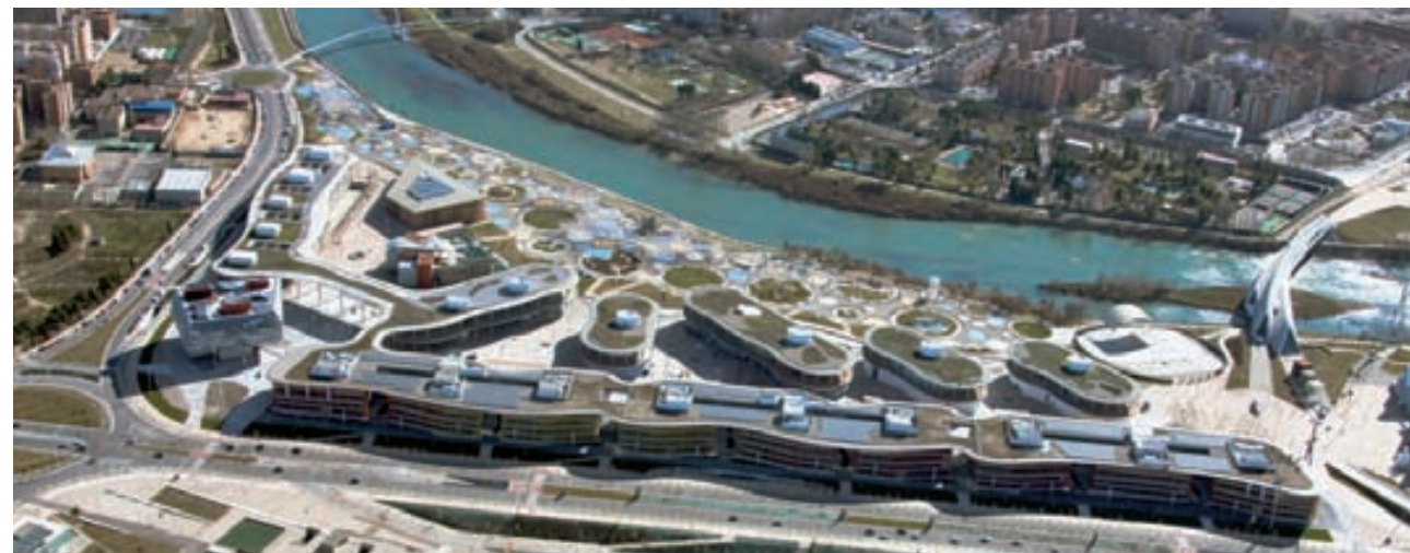
Reconversión Edificio Ronda 1 (Expo Zaragoza 2008) en un nuevo Centro de Negocios, Cultura y Ocio de Zaragoza
