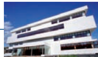
Edificio multiusos, Ayuntamiento de Telde
