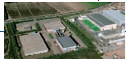
Desalbradora de El Mojón, Murcia
