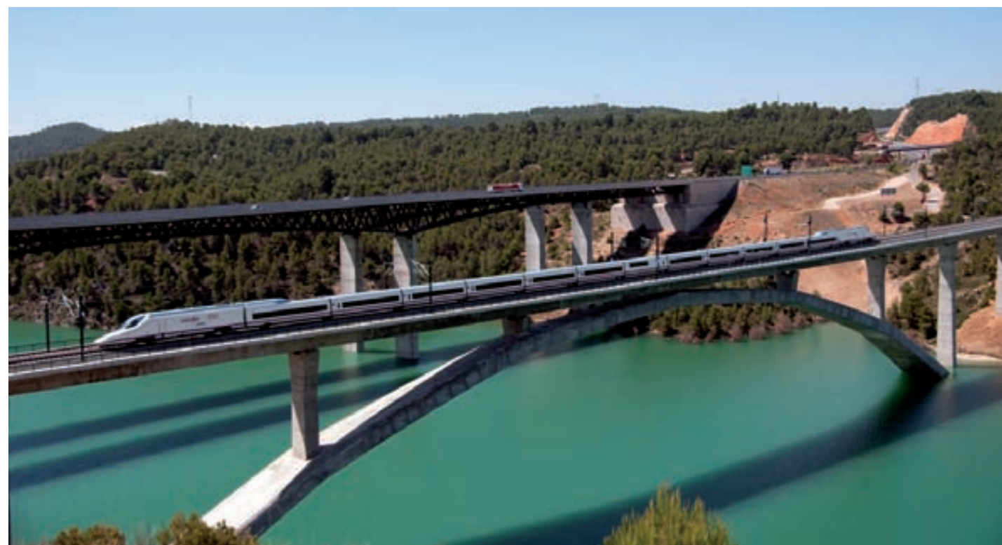
■ Tramo Embalse de Contreras - Villargordo del Cabriel. AVE Madrid - Valencia Longitud. 6,5 km. Viaductos. 3 Túneles. 3 Viaducto de Contreras. Mayor arco ferroviario de hormigón de Europa y récord absoluto de España (261 m. de luz) Premio Internacional Puente de Alcántara
