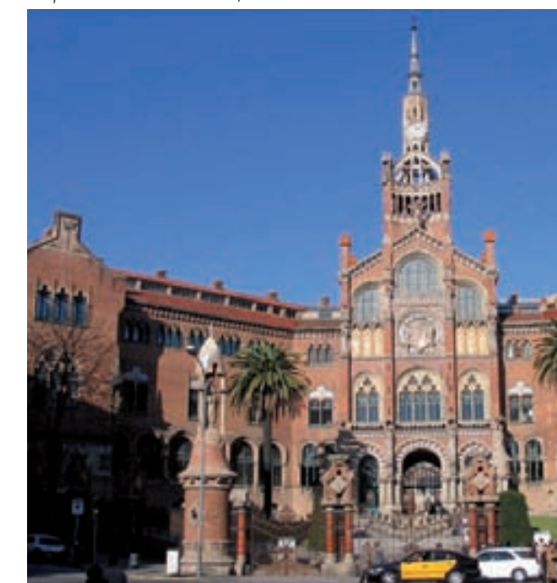
Hospital Santa Creu i Sant Pau, Barcelona
