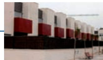
Viviendas VIVA, Valladolid
