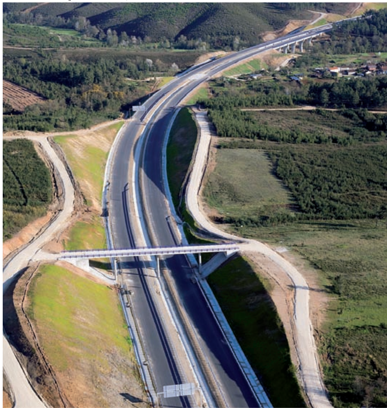
Tramo Verín - Frontera Portuguesa de la autovía A-75, Orense
