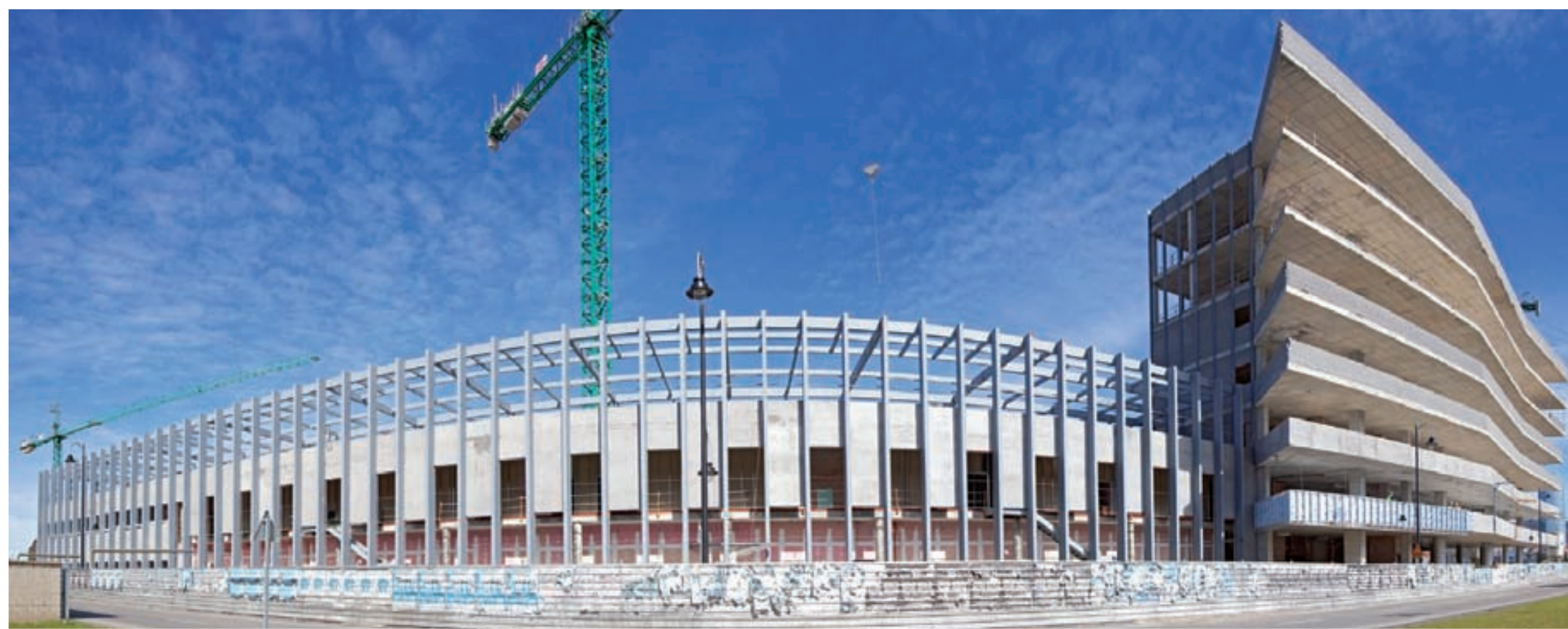
■ Clínica IMQ, Bilbao Superficie parcela. 9.200m 2 Superficie hospitalaria. 25.466m 2 Total camas. 157 Cuidados intensivos. 14 Quirófanos. 9 Plazas aparcamiento. 450 Arquitectos. Carlos Ferrater y Alfonso Casares
