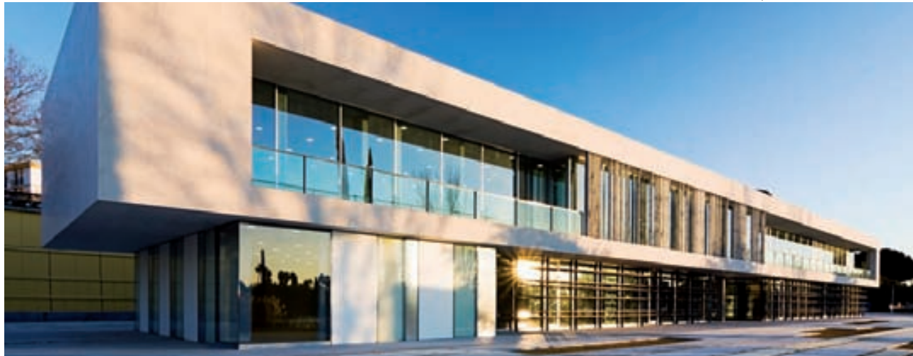
Biblioteca Municipal en la calle Torneo, Sevilla
