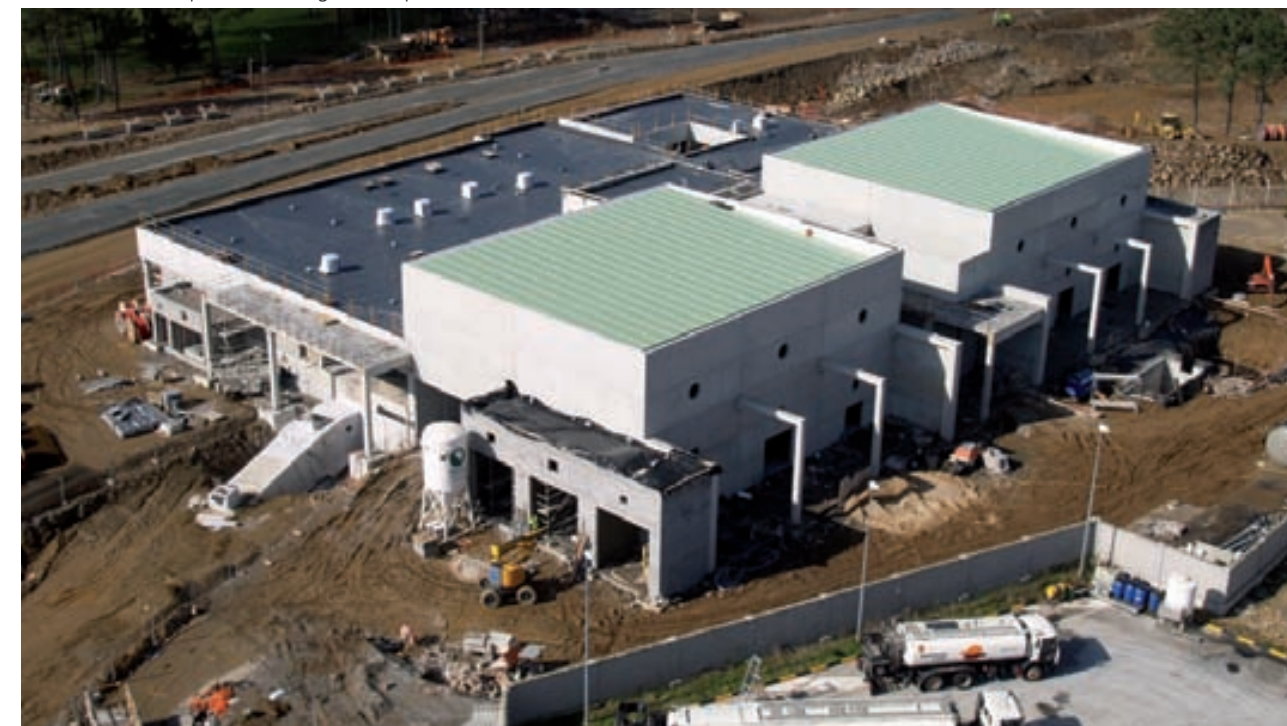
Central Eléctrica, Aeropuerto de Santiago de Compostela
