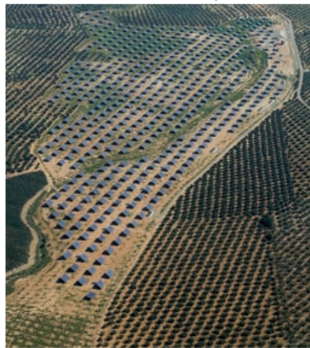
Planta de Generación Eléctrica Fotovoltaica de El Gallo, Jaén
