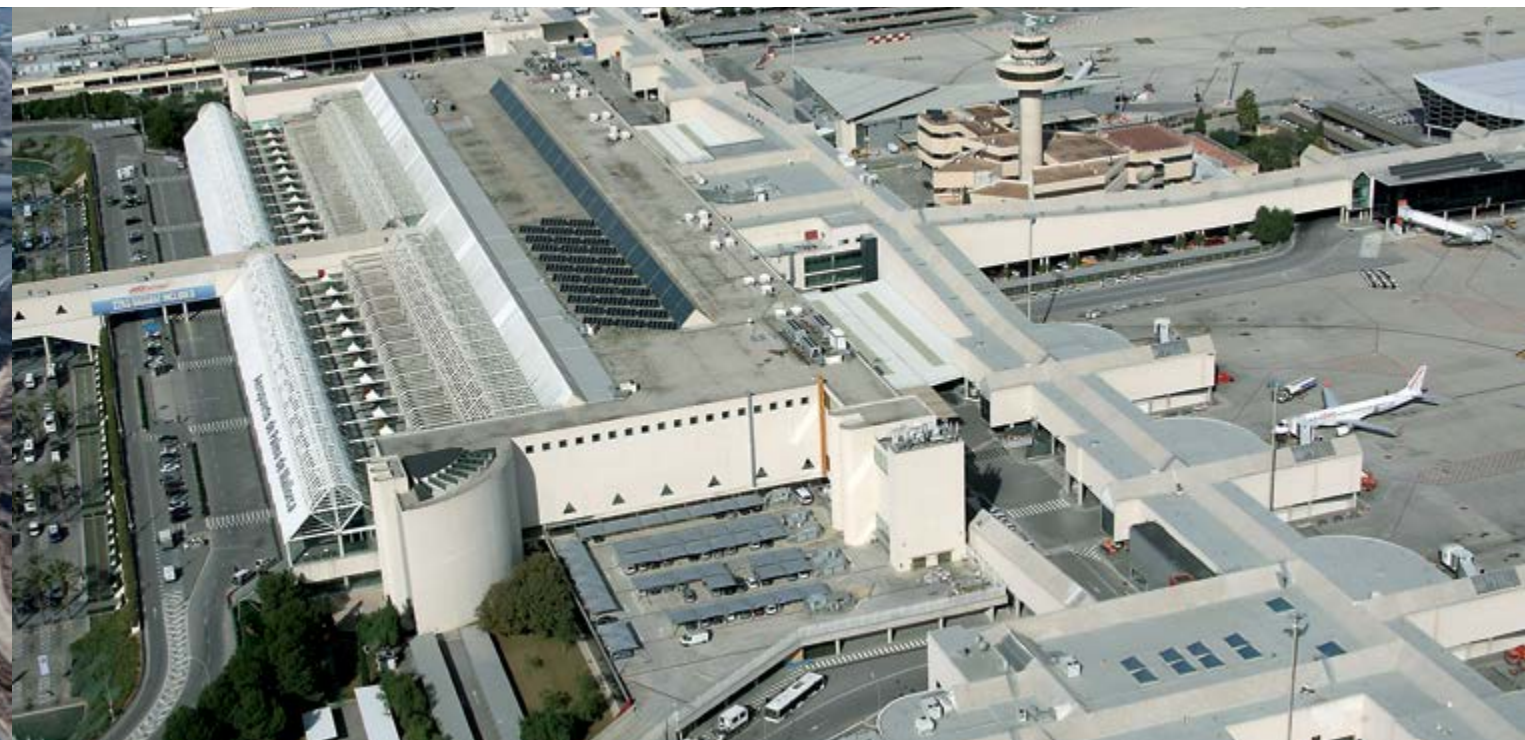
Nueva impermeabilización del edificio terminal y módulos del Aeropuerto de Palma de Mallorca (España)
