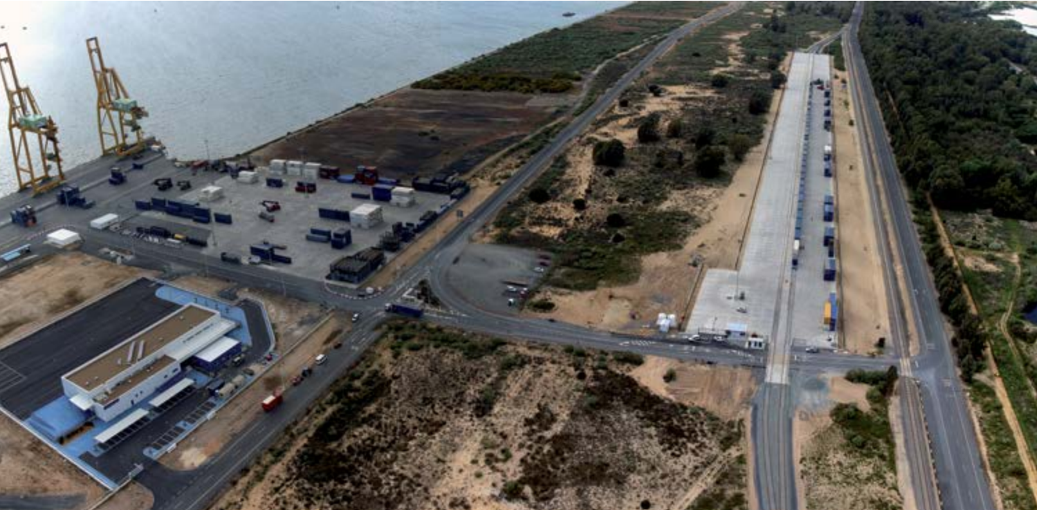
Terminal Ferroviaria Muelle Sur del Puerto de Huelva (España)
