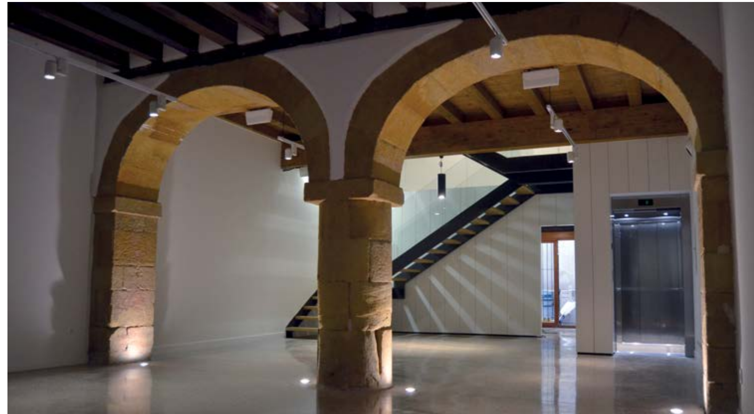
Rehabilitación de la Casa Kapitain para su nuevo uso como Museo del Traje en Errentería, Guipúzcoa (España)
