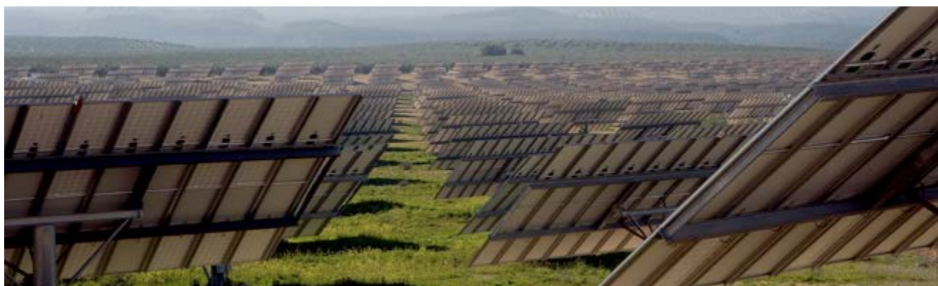
Parque solar fotovoltaico de 5,4 MW en Alcaudete, Jaén (España)
