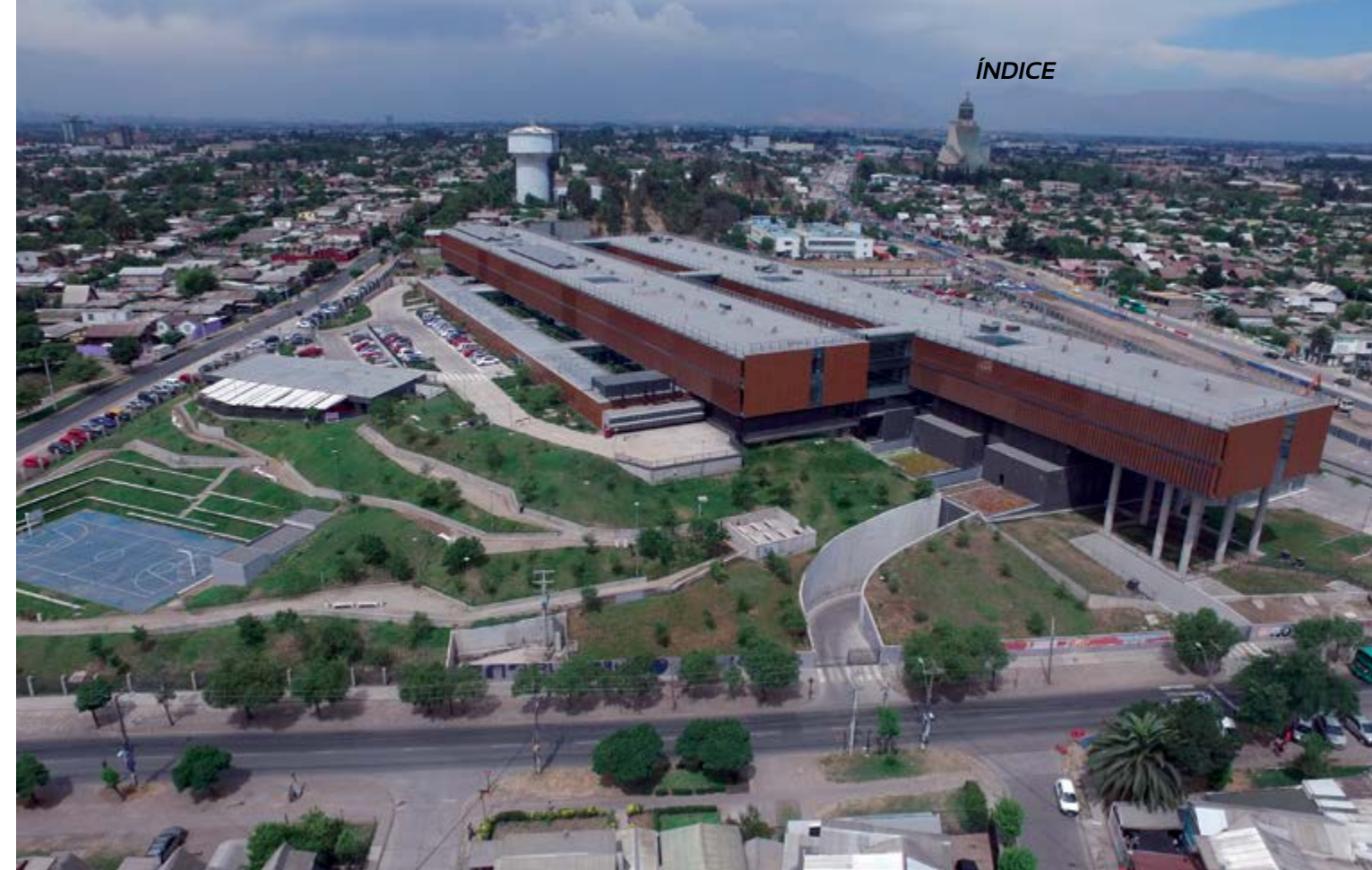
Hospital El Carmen Dr. Luis Valentín Ferrada de Maipú, Santiago de Chile. Ingeniería y proyecto GSI Solutions / Ejecución SANJOSE Constructora
