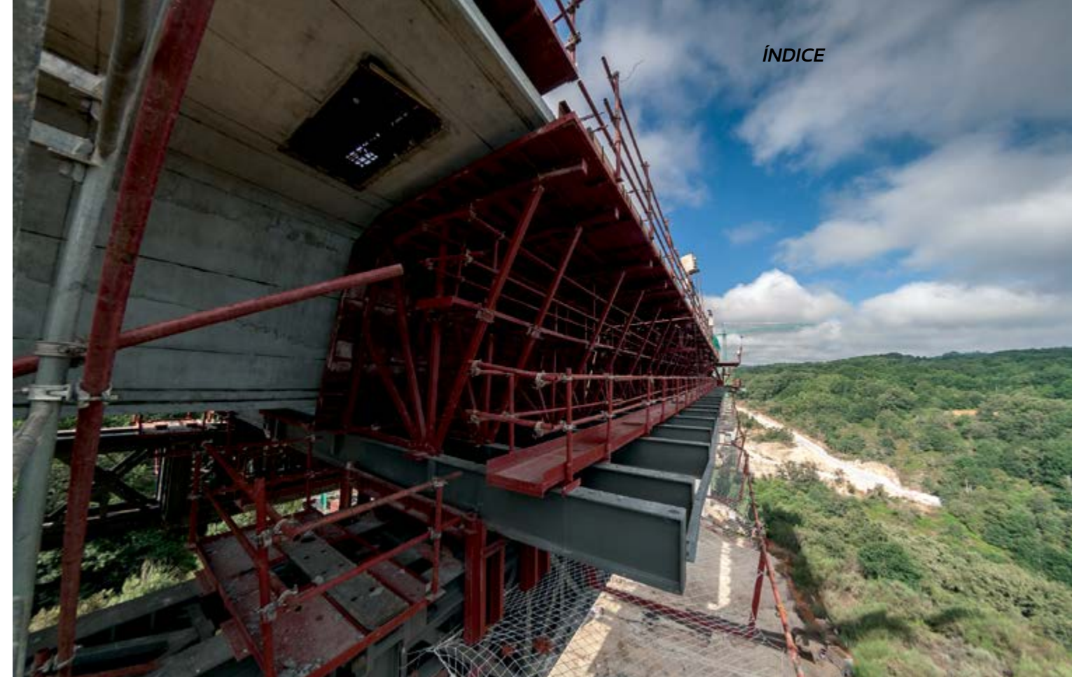
Tramo Miamán - Ponte Ambía (Orense). AVE Madrid - Galicia (España)
