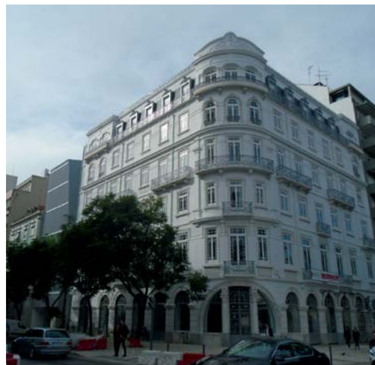
Edificio República 37, Lisboa (Portugal)
