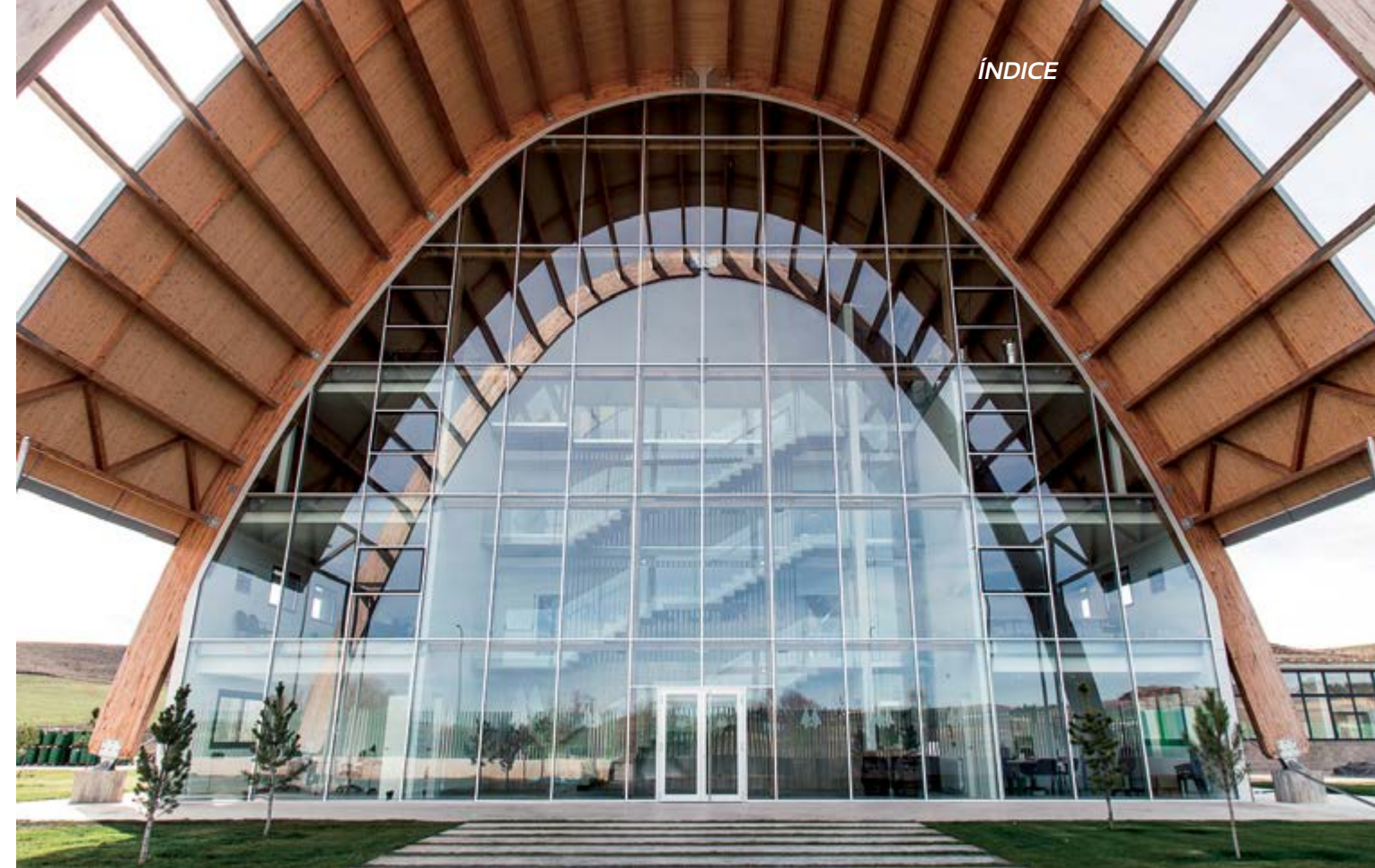
Construcción integral de la planta para la destilación de resina en Almazán, Soria (España)
