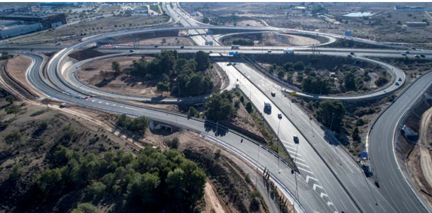
Modificación del enlace de las autovías A-30 y A-7 y prolongación del Carril Adicional para circulación de vehículos lentos en rampa en la A-30, Murcia (España)
