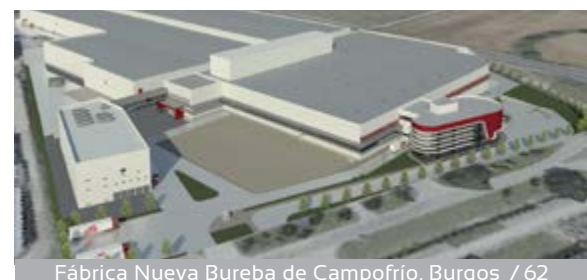
Fábrica Nueva Bureba de Campofrío, Burgos / 62
