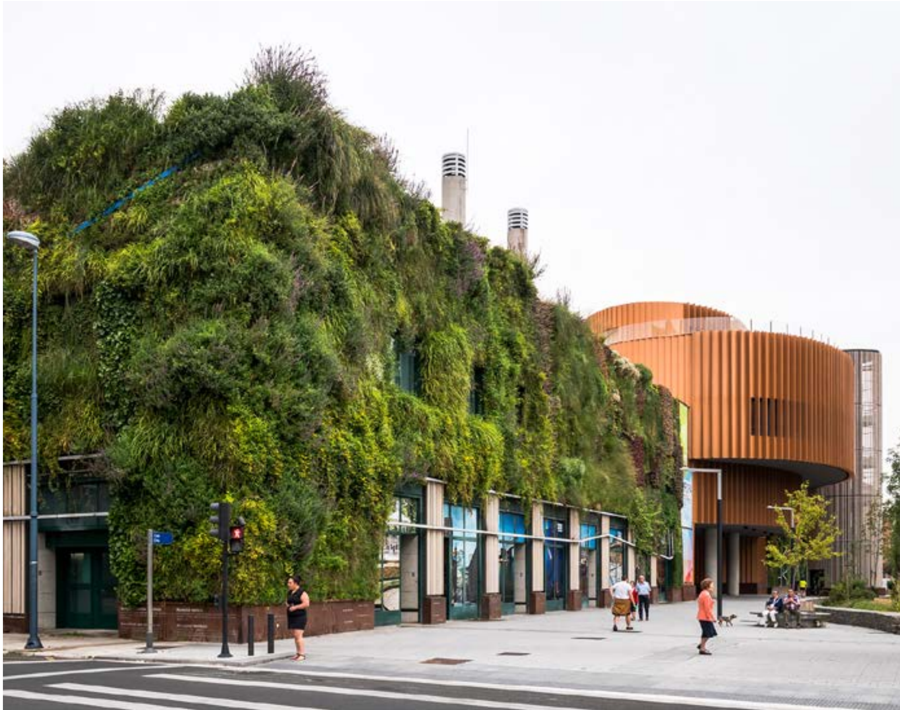
Gestión del suministro energético de electricidad, optimización y mantenimiento con garantía total de 42 edificios del Ayuntamiento de Vitoria. Palacio de Congresos Europa, Vitoria-Gasteiz, Álava
