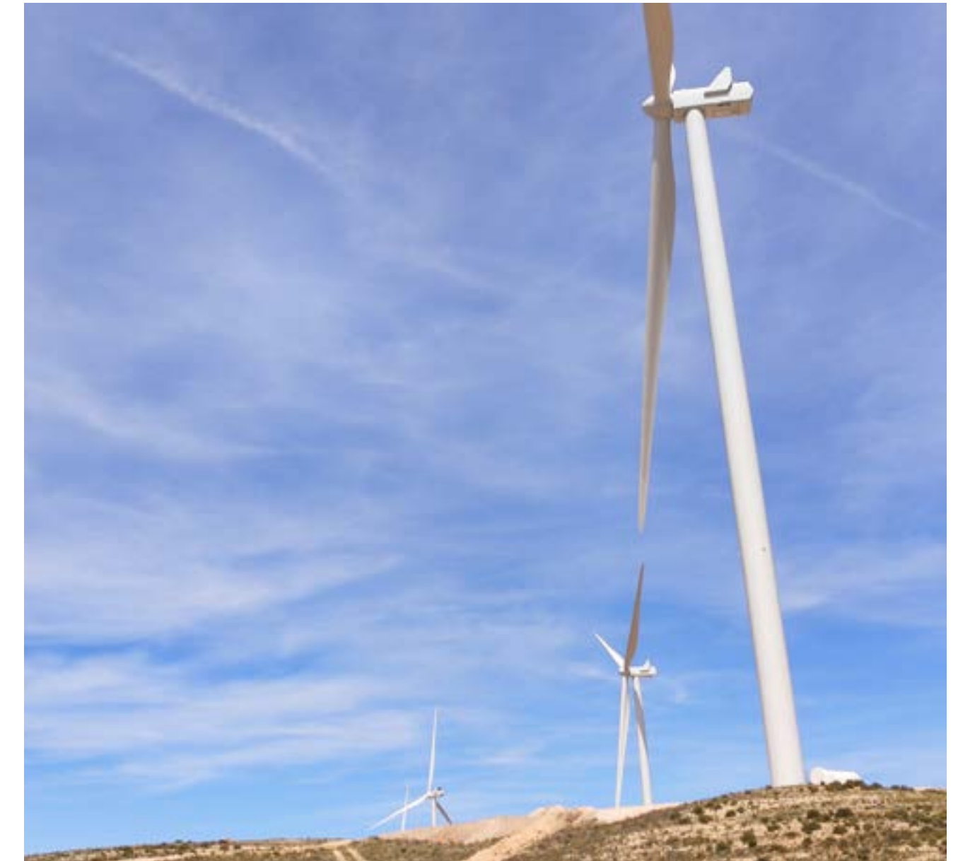
Parques eólicos para Enel Green Power en Teruel (España)
