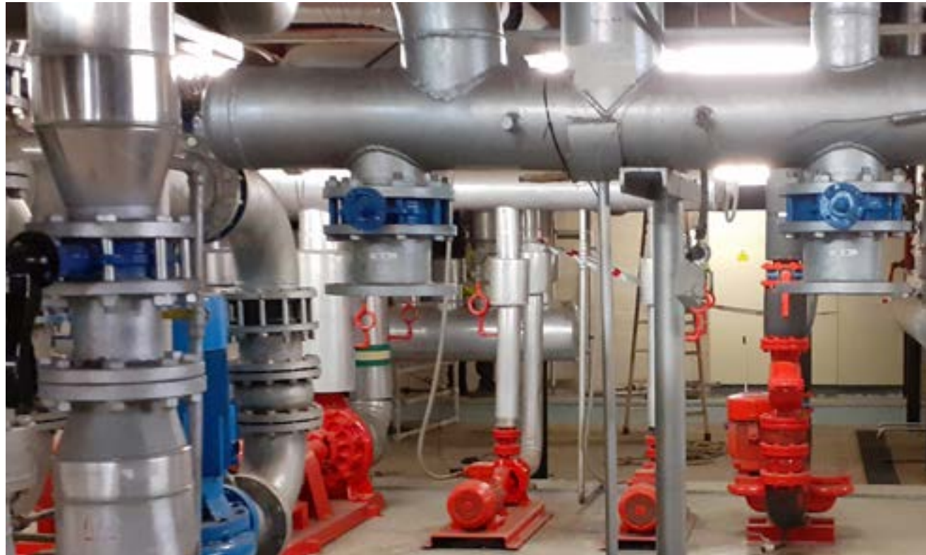
Reforma climatización de los estudios de Radio Televisión Española en Sant Cugat del Vallés, Barcelona
