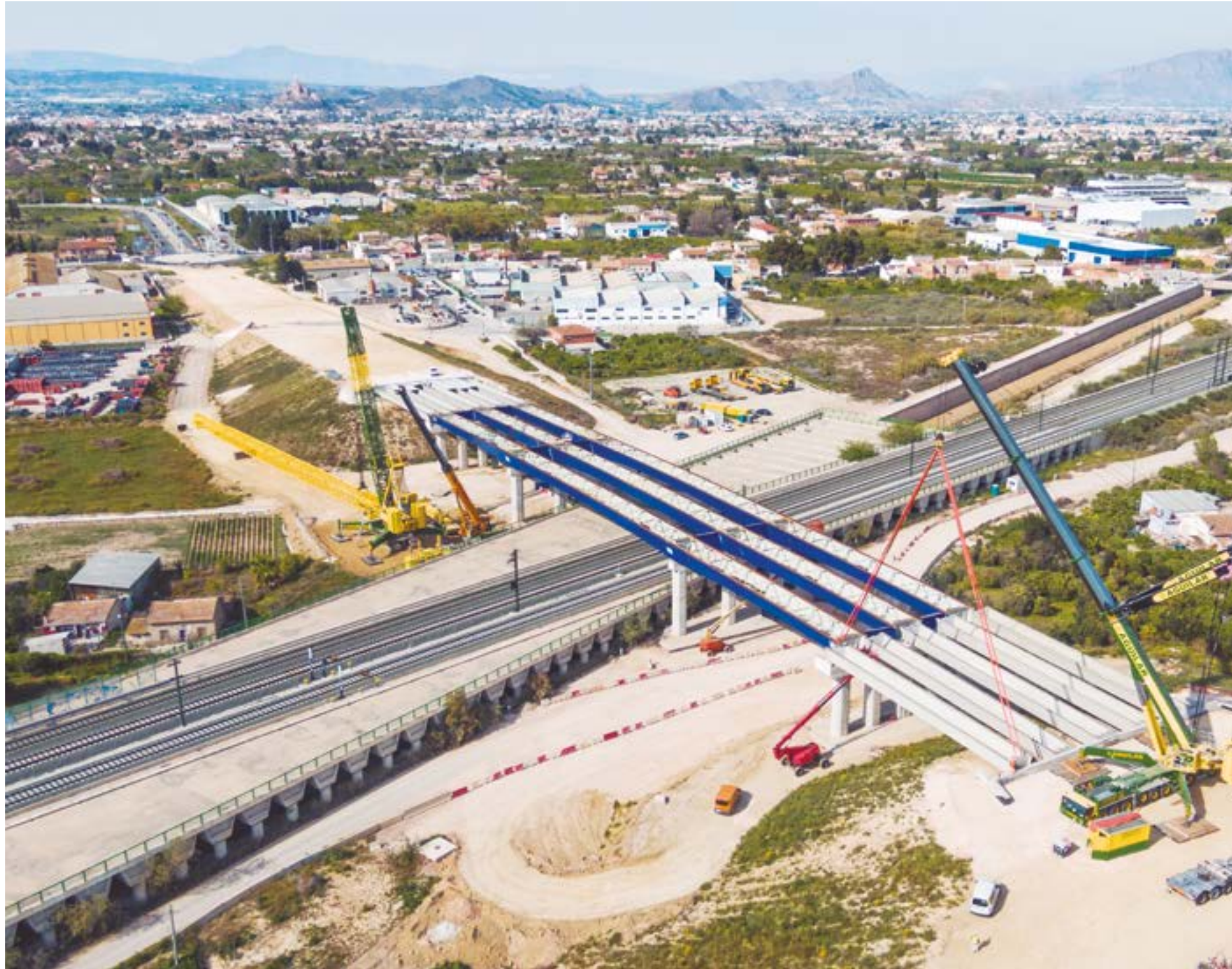
Tramo Autovía del Reguerón de la Circunvalación MU-30 de Murcia (España)
