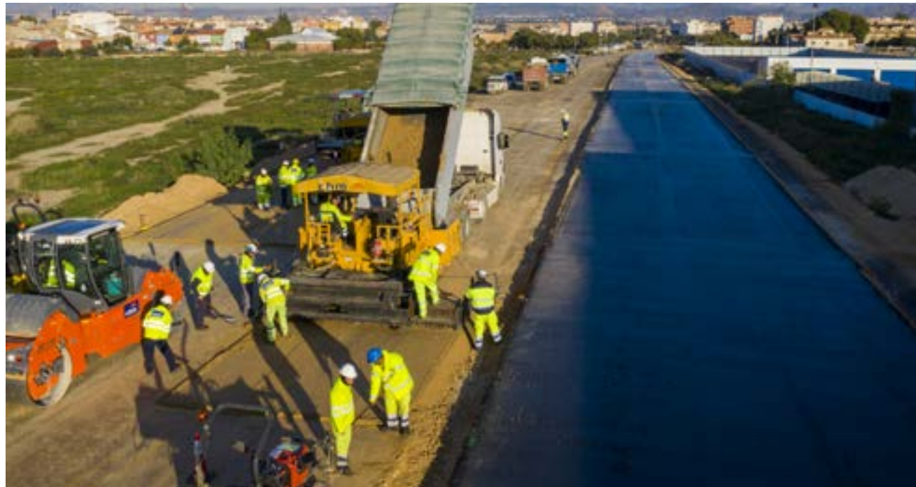
Equipo humano en la obra Tramo Autovía del Reguerón de la Circunvalación MU-30 de Murcia (España)
