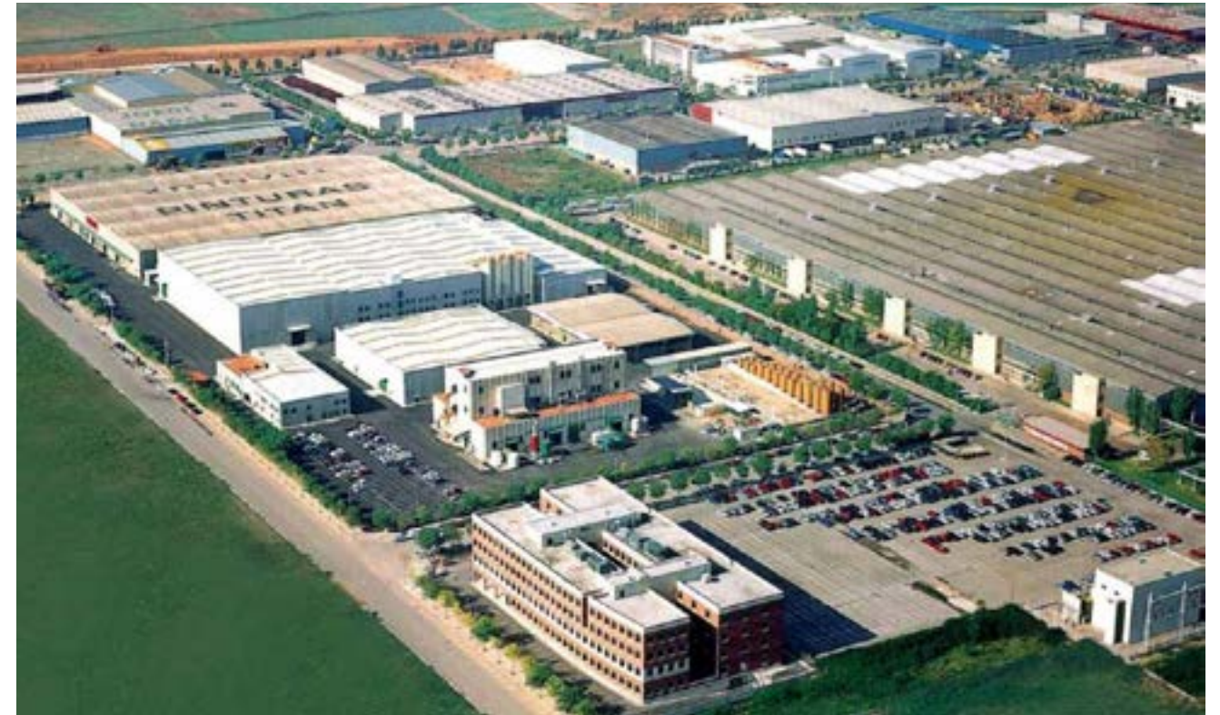
Instalaciones mecánicas y eléctricas en la Fábrica de Titanlux en El Prat de Llobregat, Barcelona
