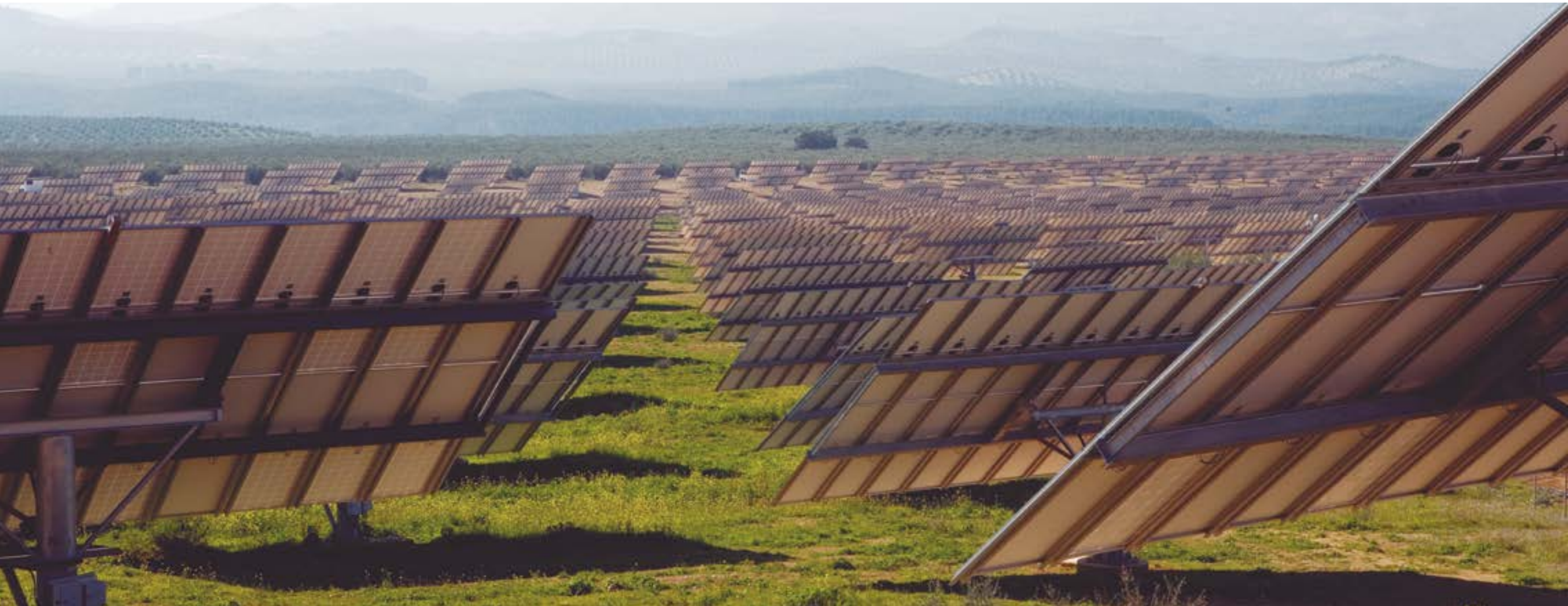
Planta fotovoltaica en Alcaudete, Jaén / 5,4 MW
