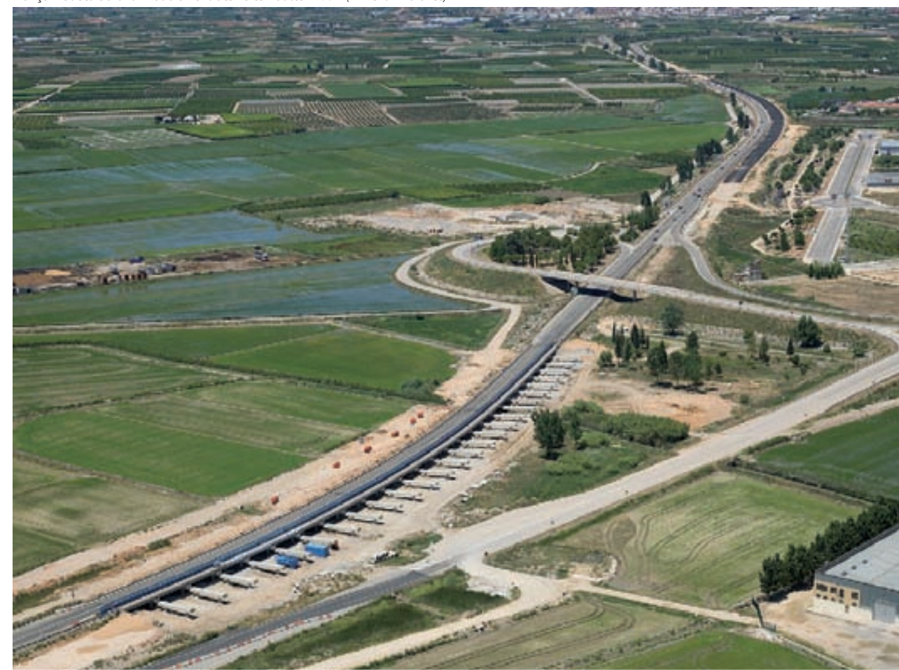
Tronçon: Sueca-Sollana. Doublement des voies Routes N-332 (Almería - Valence)
