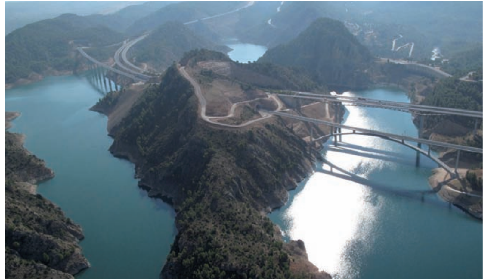
Tonçon Barrage de Contreras - Villargordo del Cabriel, AVE Madrid - Valence
