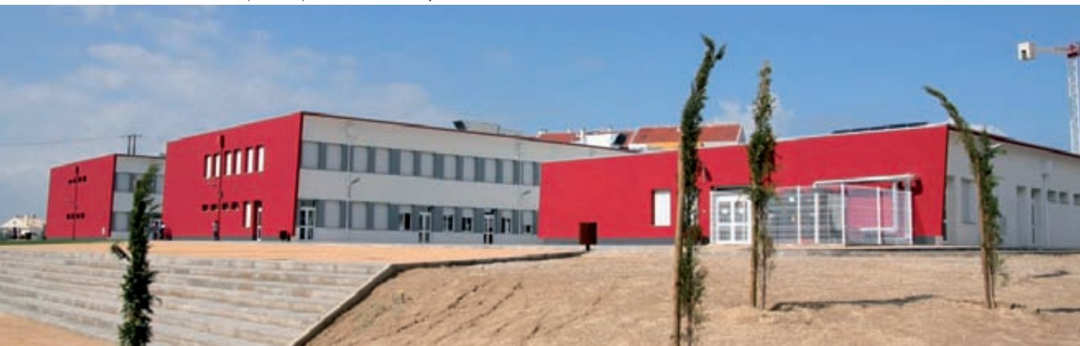
Ecole, Garderie et Pavillon sportif du quartier de Areias, Montijo
