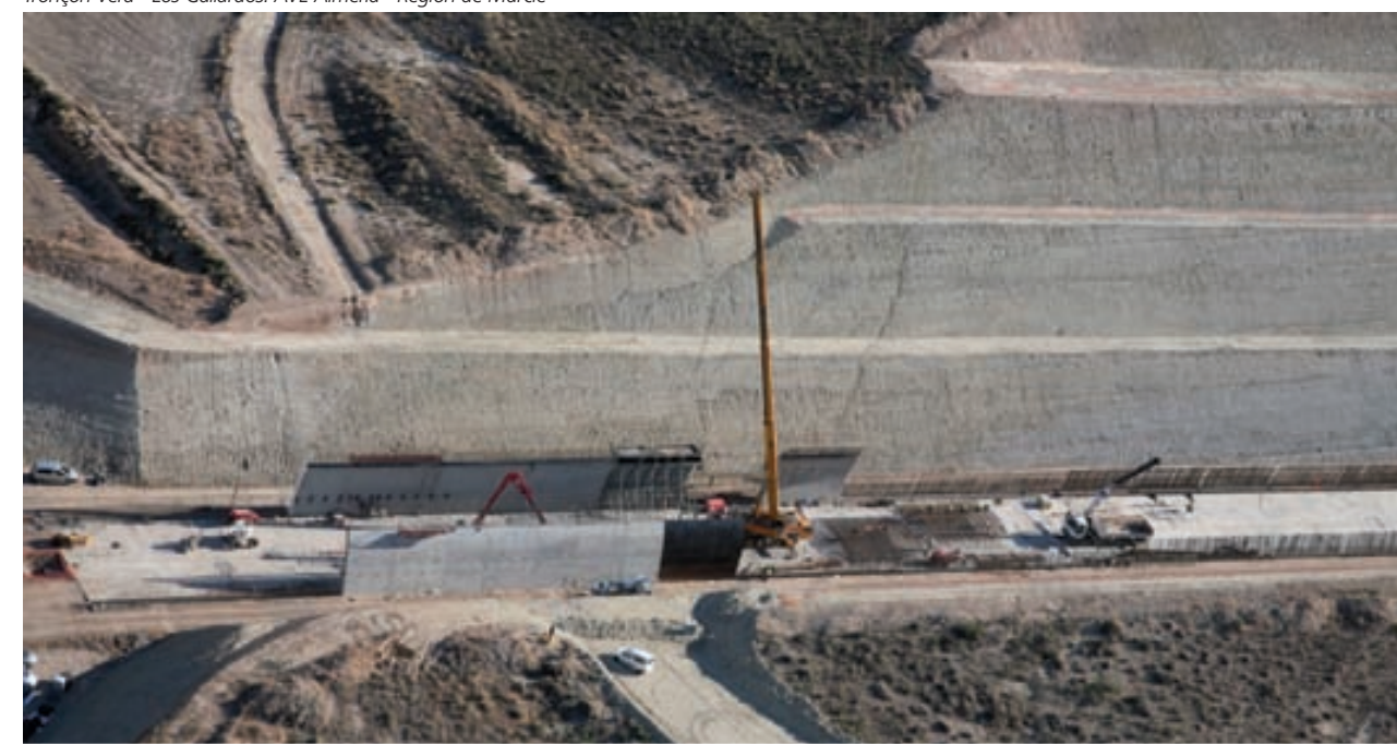
Tronçon Vera - Los Gallardos. AVE Almería - Région de Murcie
