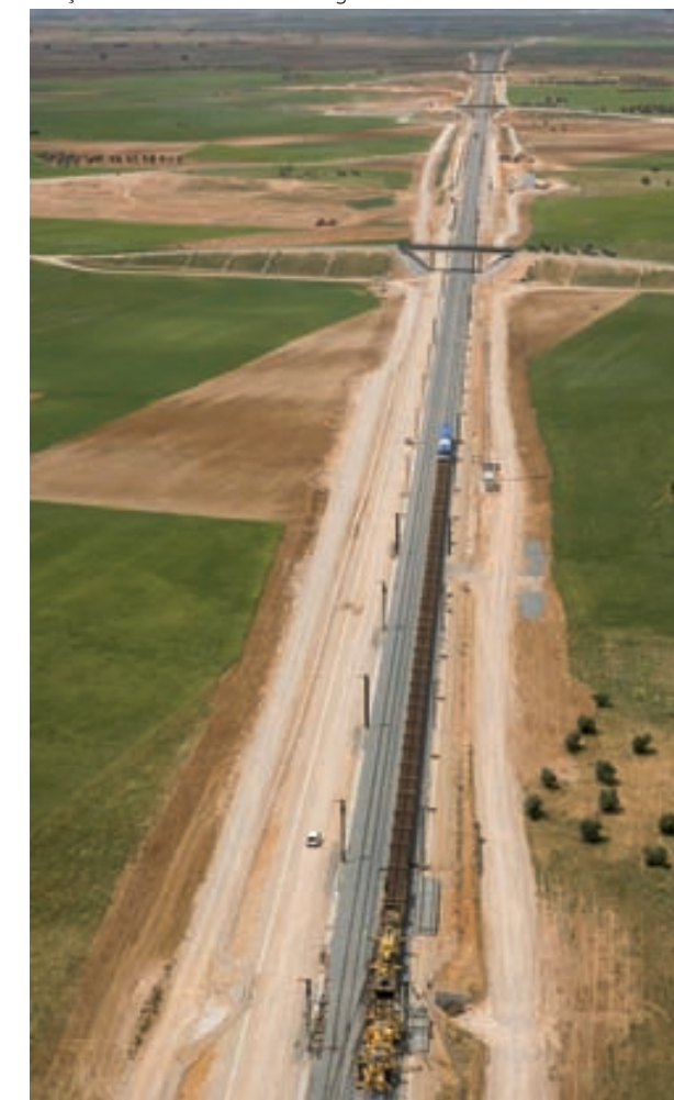
Tronçon Ocaña - Villarubia de Santiago. AVE Madrid - Valence
