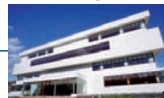
Bâtiment Multiusages, Mairie de Telde
