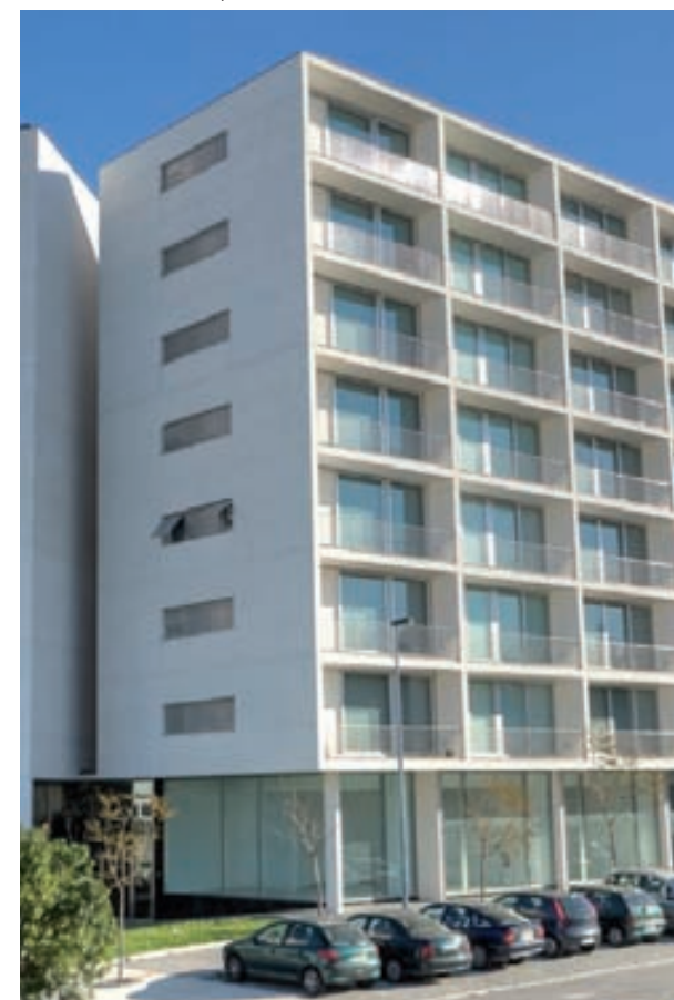
Bâtiment Casas Brancas, Porto
