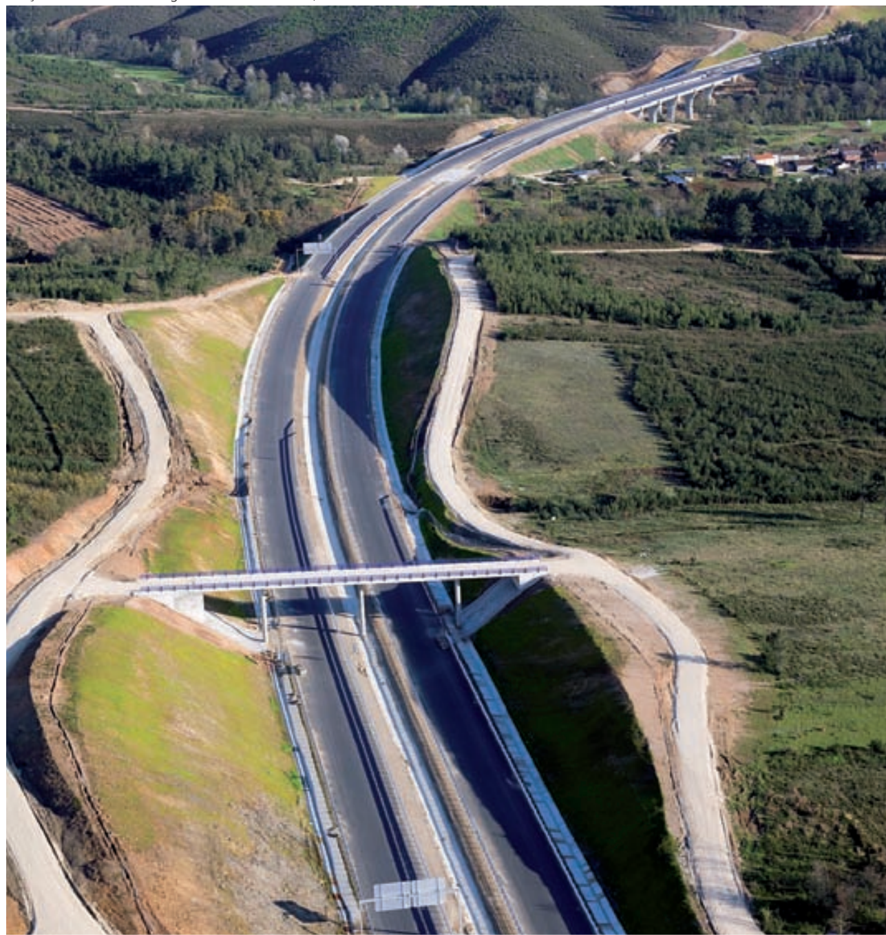
Tronçon Verín - Frontière Portugaise de l'autoroute A-75, Orense
