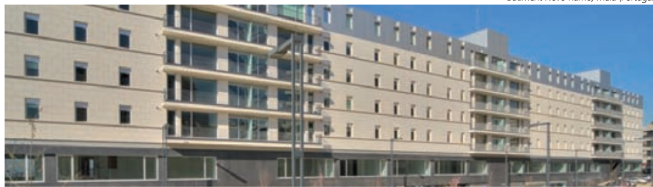
Bâtiment Novo Rumo, Maia (Portugal)
