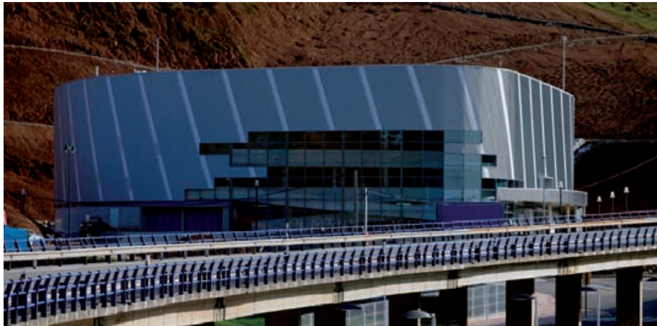
Auditorium et Omnisport à Bembibre, León
