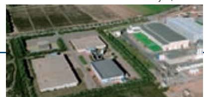
Usine de Désalinisation de El Mojón, Murcie
