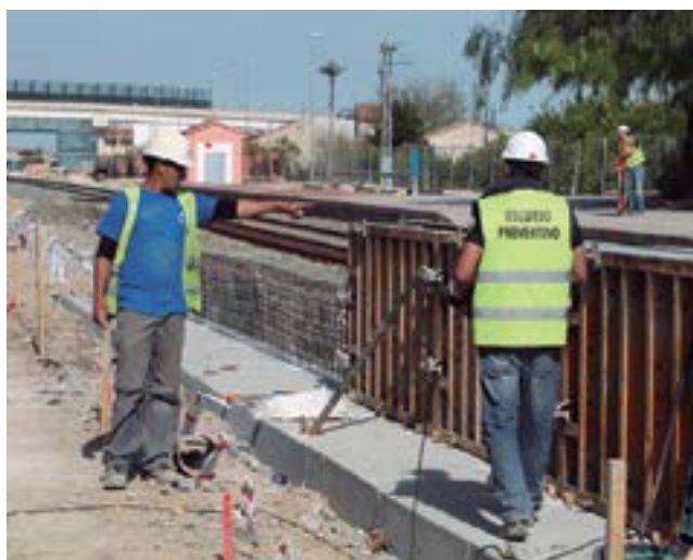
■ Tronçon Colada de la Buena Vida - Murcia
