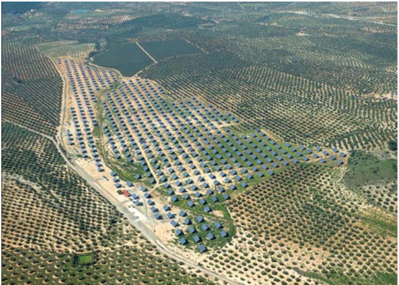
■ Centrale photovoltaïque à Alcaudete, Jaén / 5,4 MW
