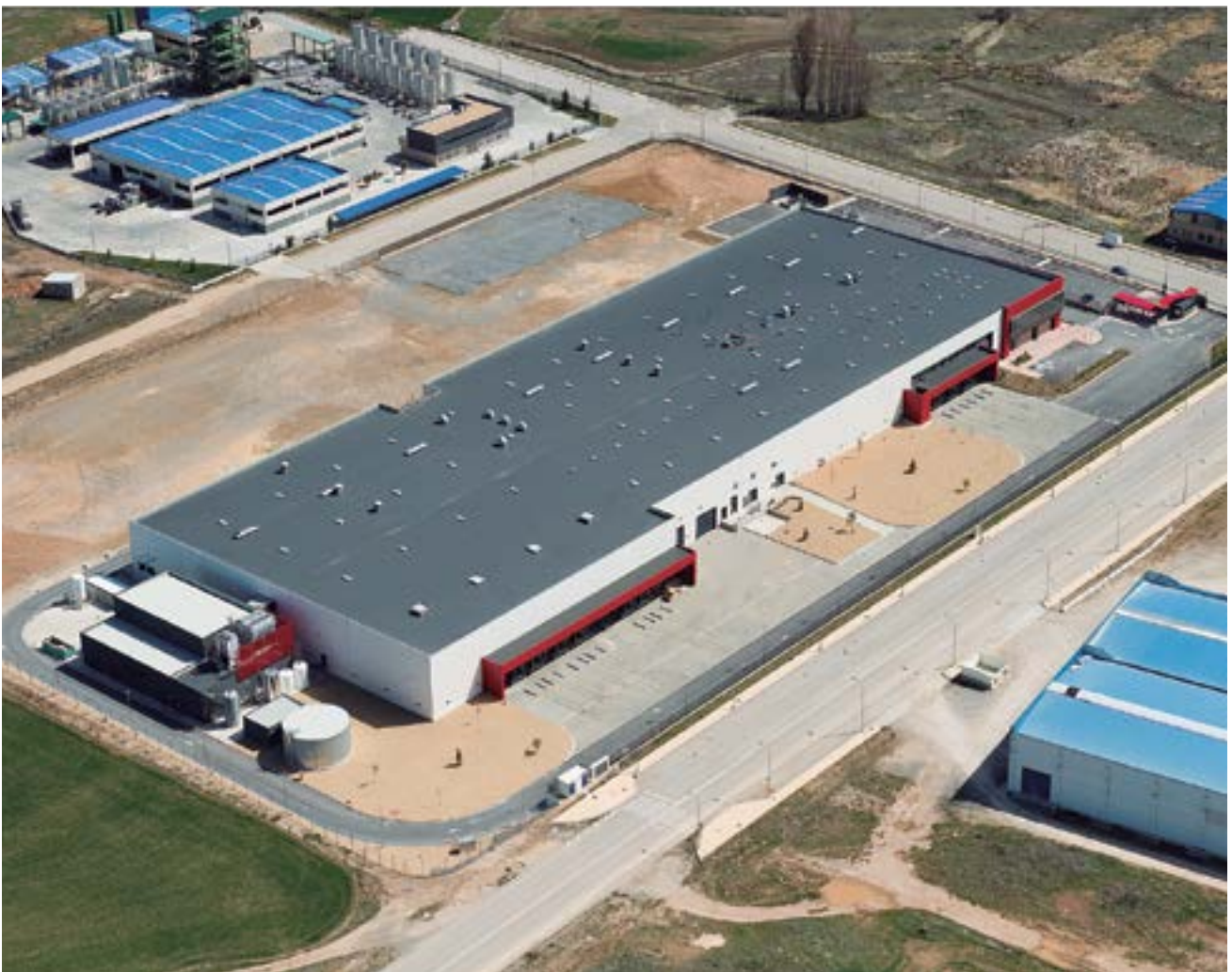
■ Réforme installations de l'Usine de Campofrío à Olvega, Soria
