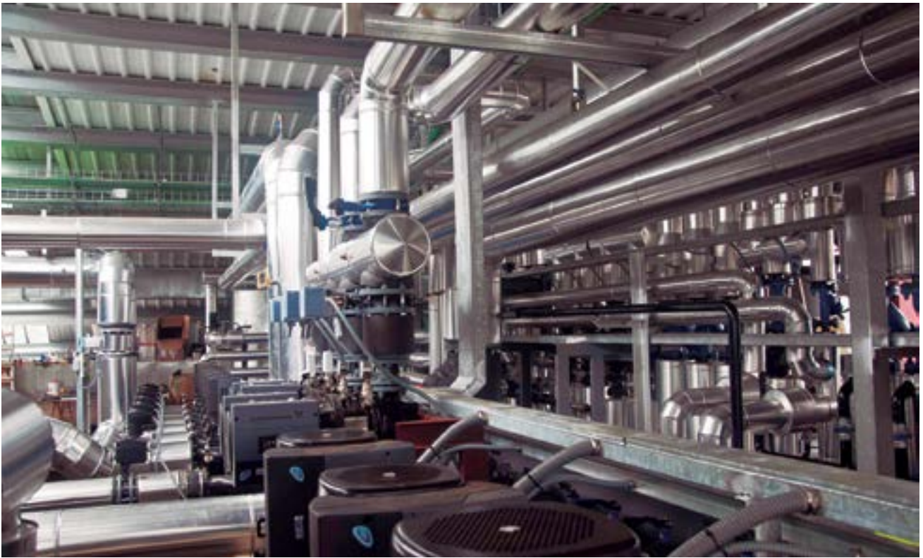
■ Installations électriques du Bâtiment Terminal de l'Aéroport de Vigo
