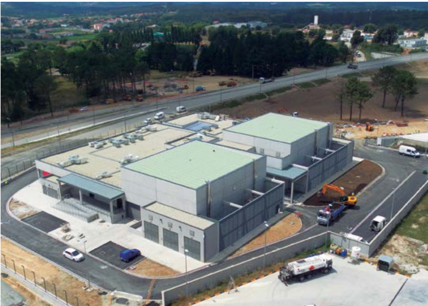
■ Centrale Électrique de l'Aéroport de Saint-Jacques de Compostelle
