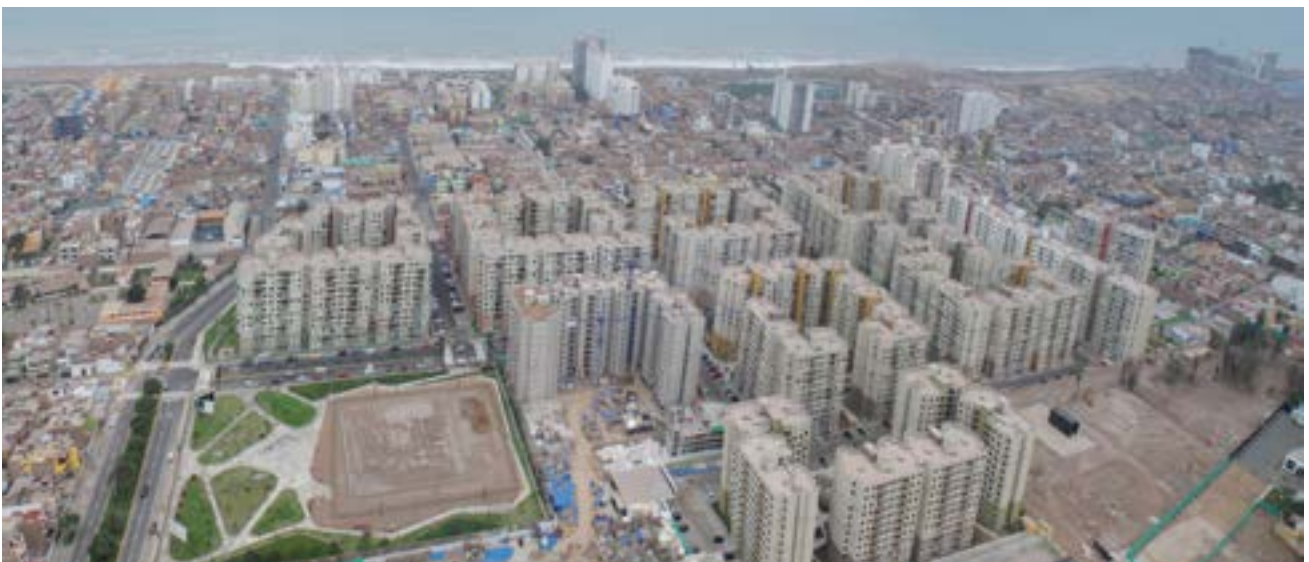
■ Condominium Parques de la Huaca, Lima (Pérou). Ingénierie et projet: GSJ Solutions / Construction. SANJOSE Constructora
