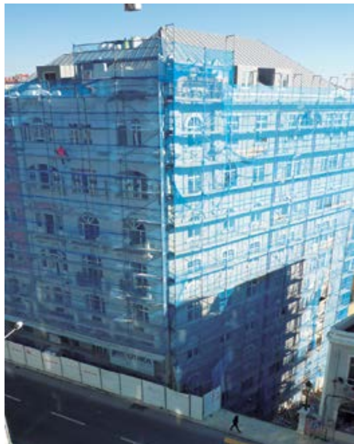
■ Réhabilitation Hôtel H10 4 étoiles, Lisbonne
