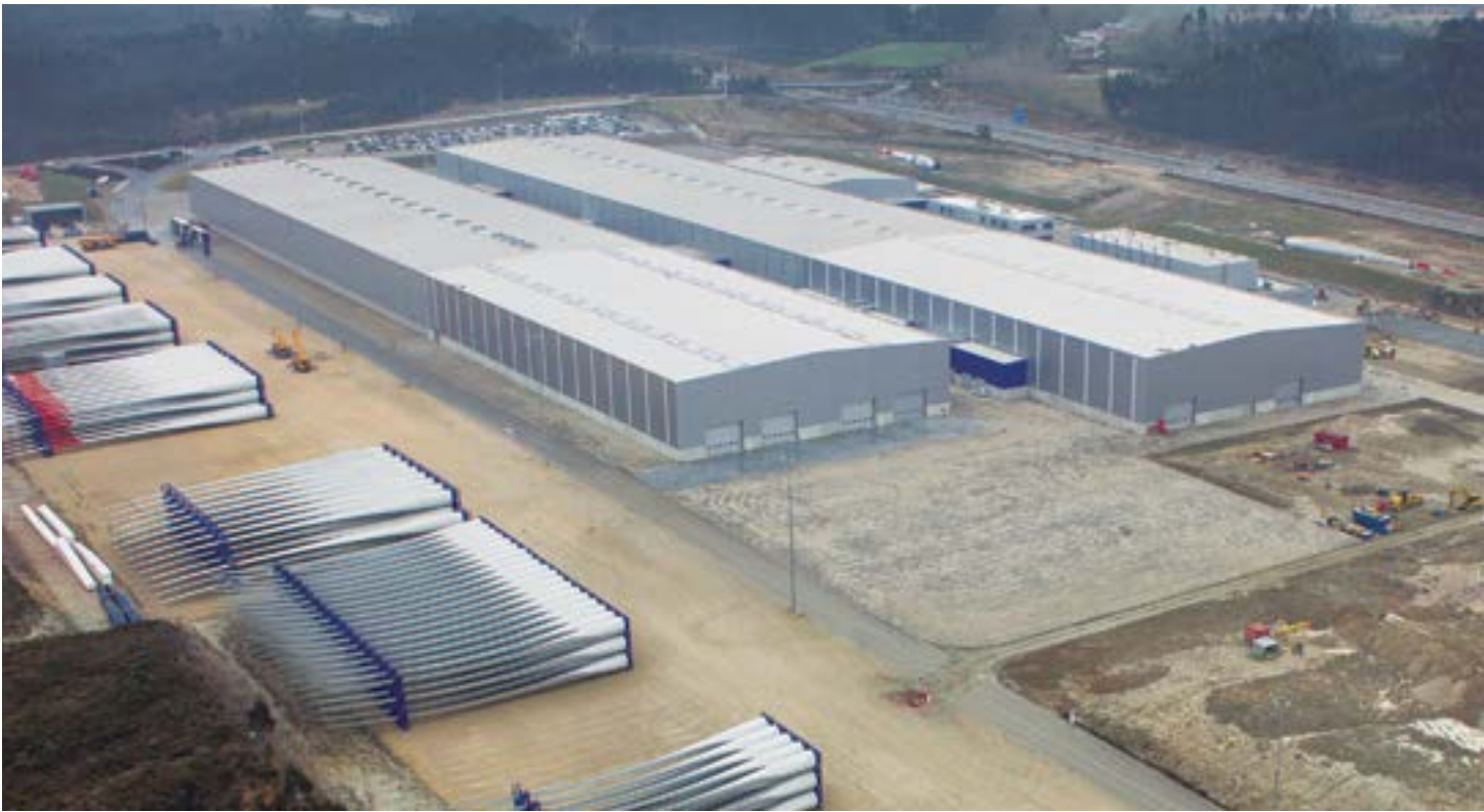
■ Extension de l'usine de Ria Blades à Vagos, Aveiro (Portugal)
