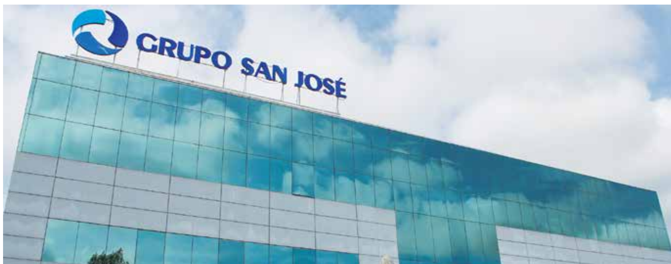
Centrale Grupo SANJOSE à Tres Cantos, Madrid
