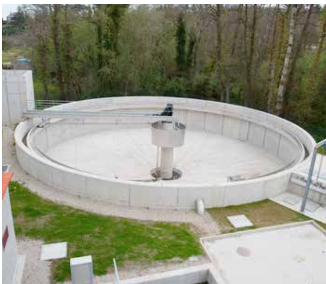
Collecteurs Généraux d'Assainissement et EDAR à Gandario – Bergondo, La Corogne. Ingénierie et projet: GSJ Solutions
