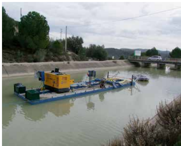
Modernisation de l'infrastructure hydraulique pour l'amélioration de l'efficacité du canal principal de la zone d'irrigation de Genil - Cabra, Cordoue
