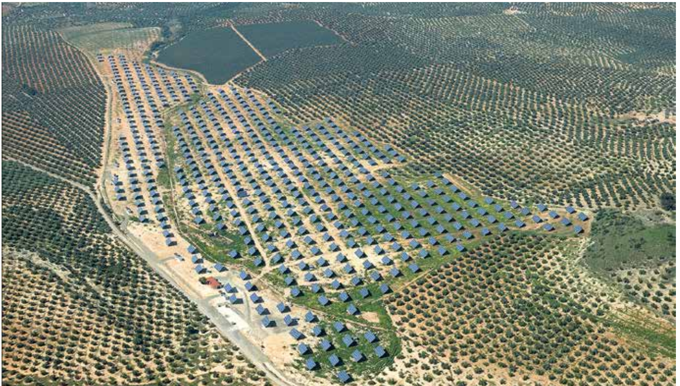
Centrale photovoltaïque à Alcaudete, Jaén / 5,4 MW. Ingénierie et projet: G SJ Solutions / Construction. SANJOSE Constructora
