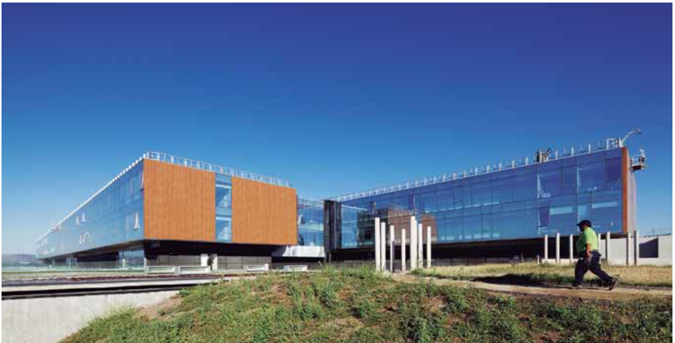
Hôpital El Carmen Dr. Luis Valentin Ferrada, Maipú - Santiago du Chili. Ingénierie et projet: GSJ Solutions / Construction. SANJOSE Constructora
