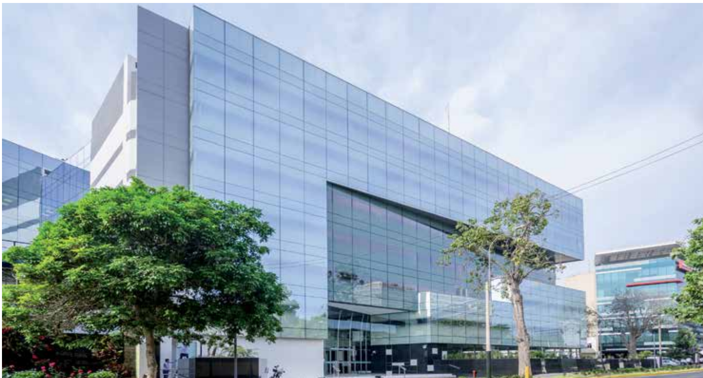
Bâtiment de bureaux Victor Andrés Belaunde à San Isidro, Lima (Pérou)
