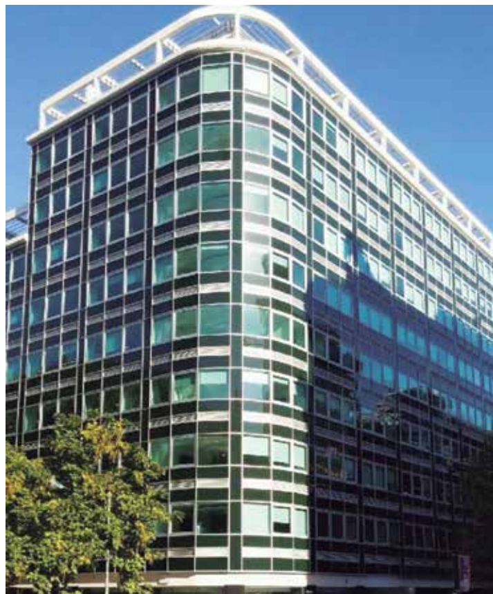
Réhabilitation du bâtiment de bureaux Rue Castilho 24 de Lisbonne (Portugal)
