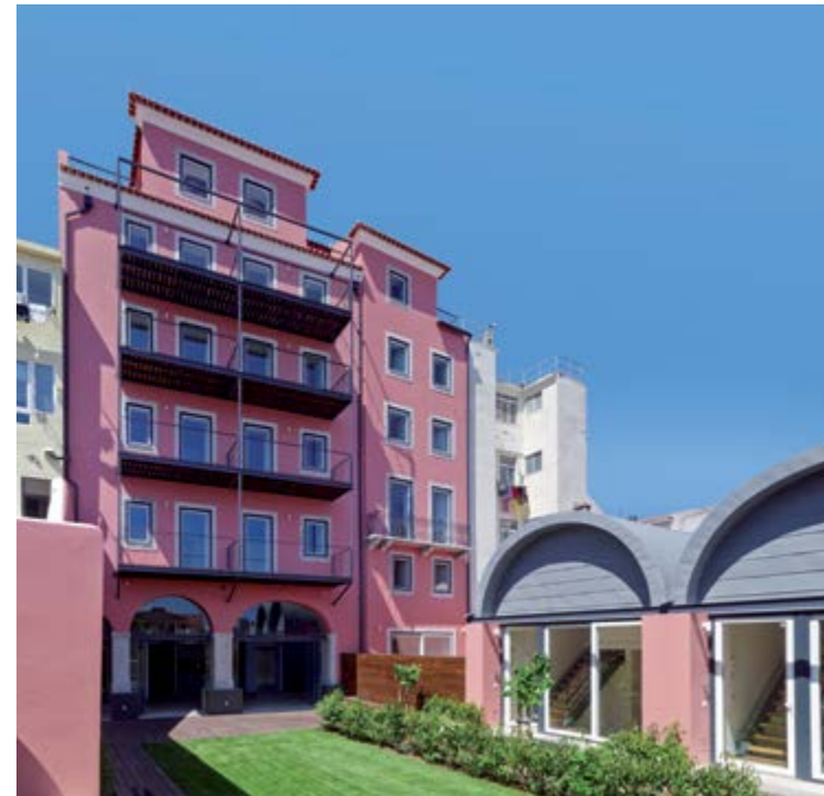
Bâtiment résidentiel rue Pedro Dias 13-19 de Lisbonne (Portugal)
