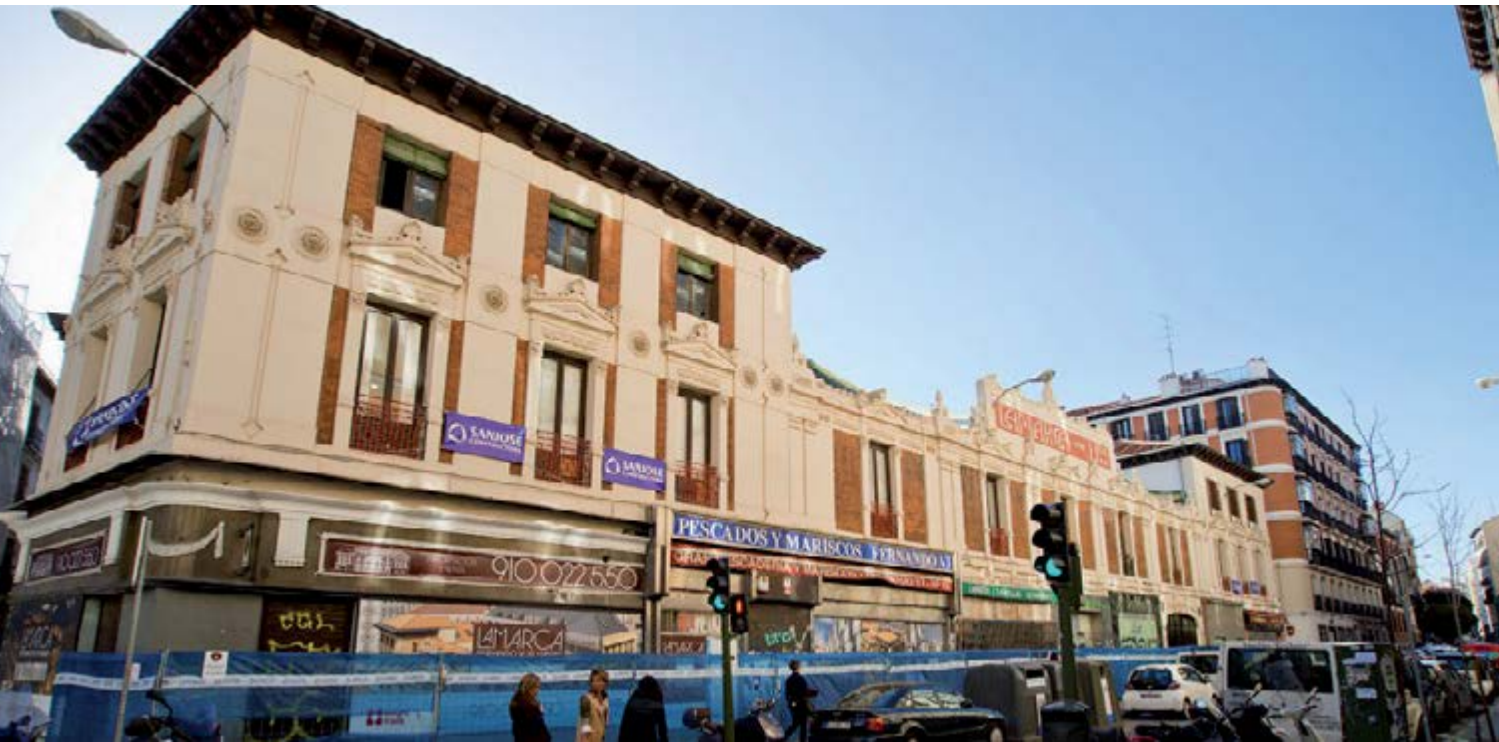
Bâtiment de logements Lamarca dans la rue Fernando VI, Madrid (Espagne)
