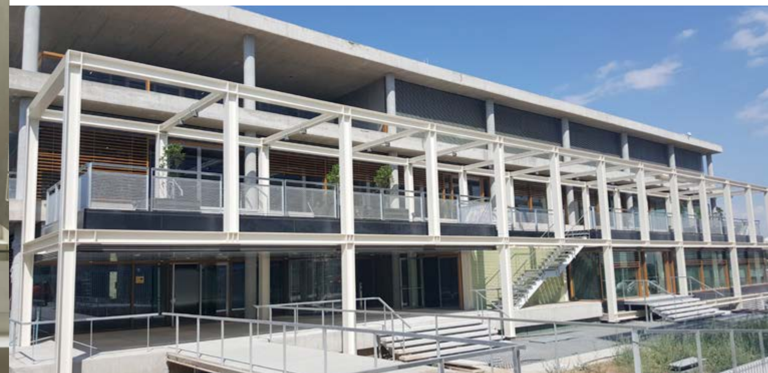
Bâtiment de Services du nouveau Siège de Banco Popular à Madrid(Espagne)
