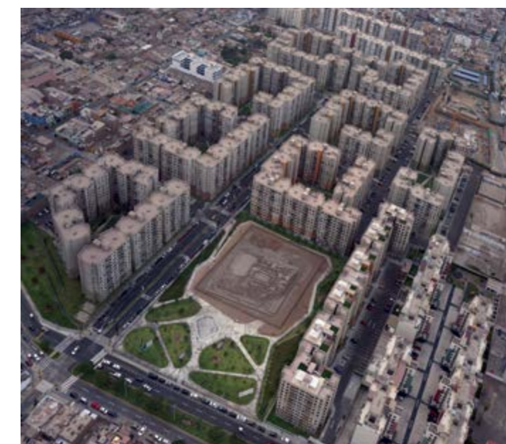
Condominium Parques de la Huaca, Lima (Pérou). Ingénierie et projet GSJ Solutions / Exécution SANJOSE Constructora
