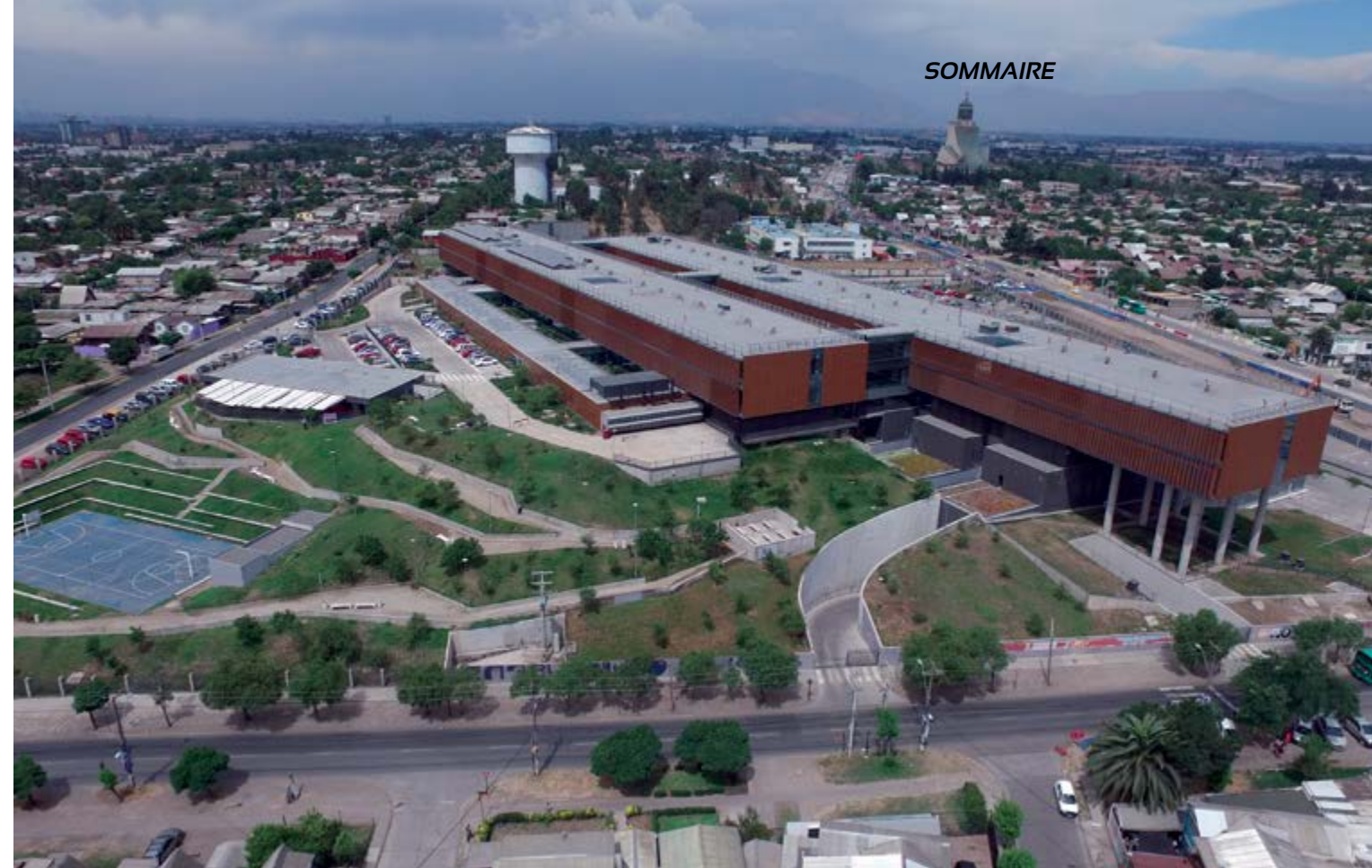
Hôpital El Carmen Dr. Luis Valentin Ferrada, Maipú - Santiago du Chili. Ingénierie et projet: GSJ Solutions / Construction: SANJOSE Constructora
