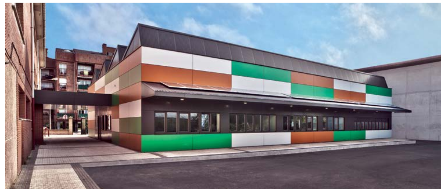
Réhabilitation du pavillon de conserves de l'Institut d'Enseignement Secondaire Zumaia BHI, Guipúzcoa (Espagne)
