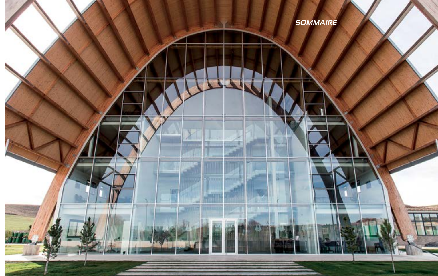
Construction intégrale de la centrale de distillation de résine à Almazán, Soria (Espagne)
