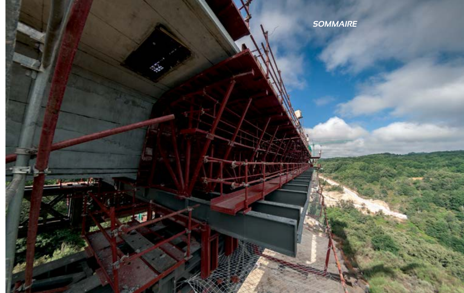
Tronçon Miamán - Ponte Ambía (Orense). AVE Madrid - Galice (Espagne)
