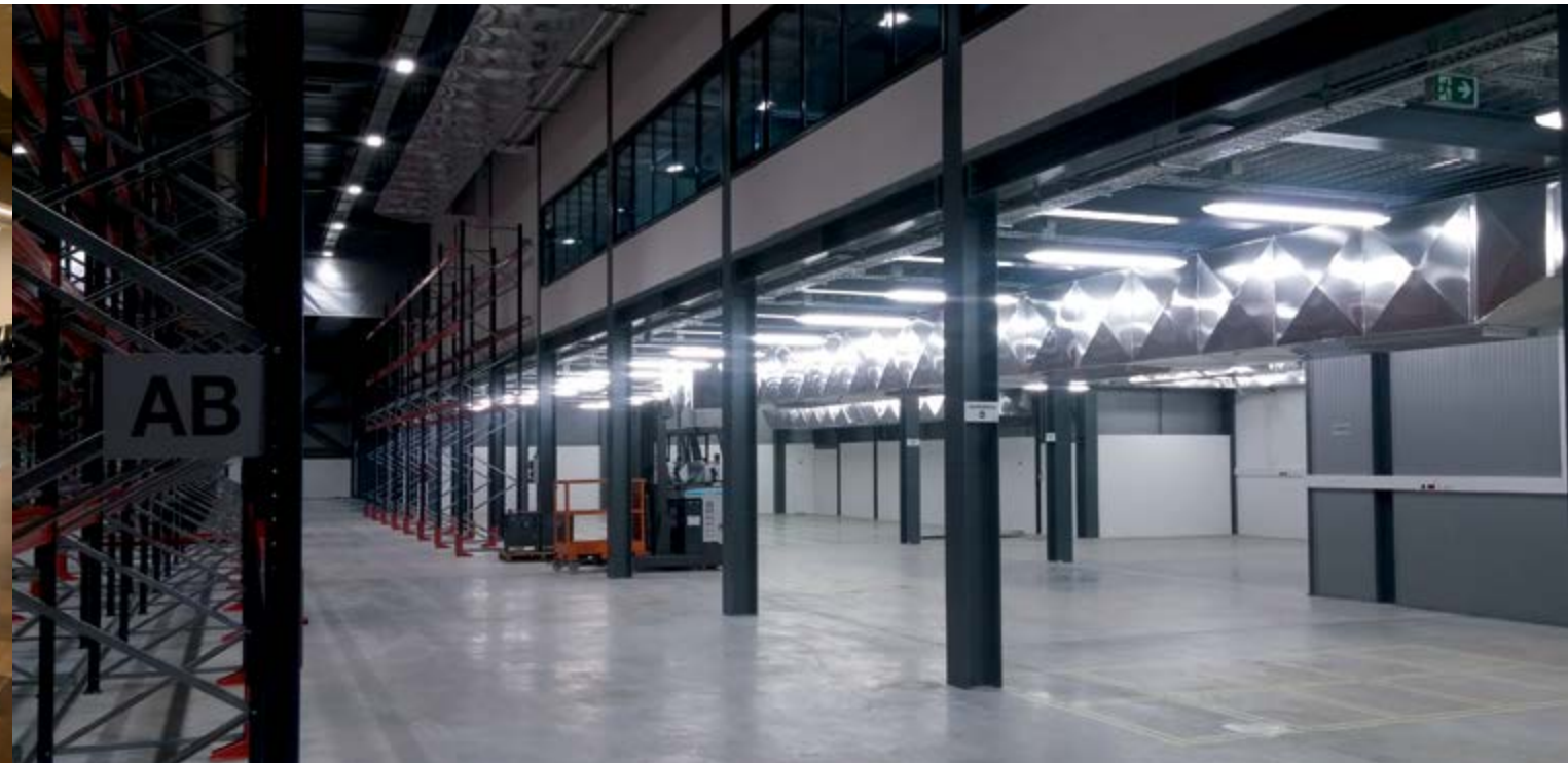
Construction intégrale de l'unité logistique de l'entreprise pharmaceutique MEDINFAR à Venda Nova, Amadora (Portugal)
